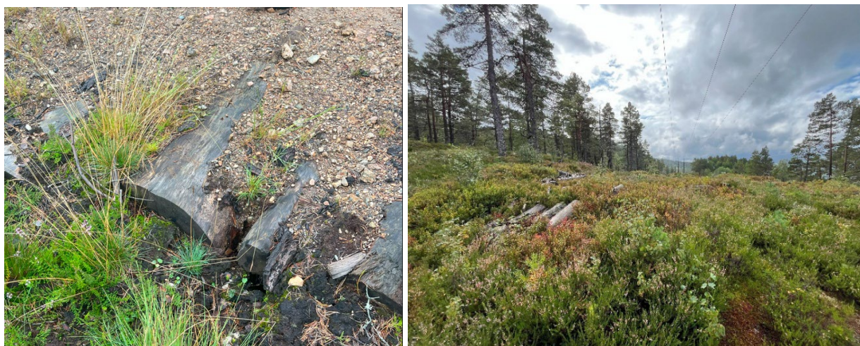
Figur 6.4.1 – Bilde til venstre viser eksempel på såkalt «trandling» for forsterkning av en permanent enkel traktorveg over myr med nedgravd tømmerstokker. Bilde til høyre viser eksempel på deponert tømmer i terrenget etter ca. 7-8 år på del av ledningstrase som det ikke var samfunnsøkonomisk å frakt tømmeret ut til veg.
