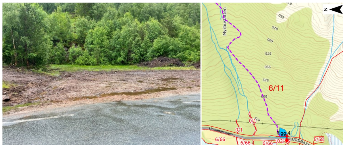
Rigg 4 ved FV4032 syd for Brøytstøl. Opparbeidet område (velteplass) på ved avkjøring til Murbuslåttan. Planlegges brukt til midlertidig oppbevaring av lettere utstyr for uttransportering med ATV og beltedumper og parkering av kjøretøy/maskiner. Bildet er tatt fra FV4032 Ljoslandsvegen. Rigg 4 berører areal tilhørende g/b-nr 6/11.
