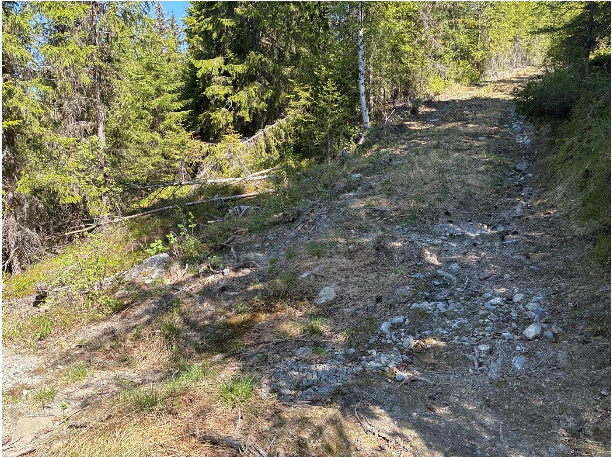
Figur 5: Lavpunkt veg på overliggende skogsbilveg har vært utløsende faktor for skredet vist i Figur 2 til Figur 4. Bildet er tatt på kote + 563, og ser mot øst.
