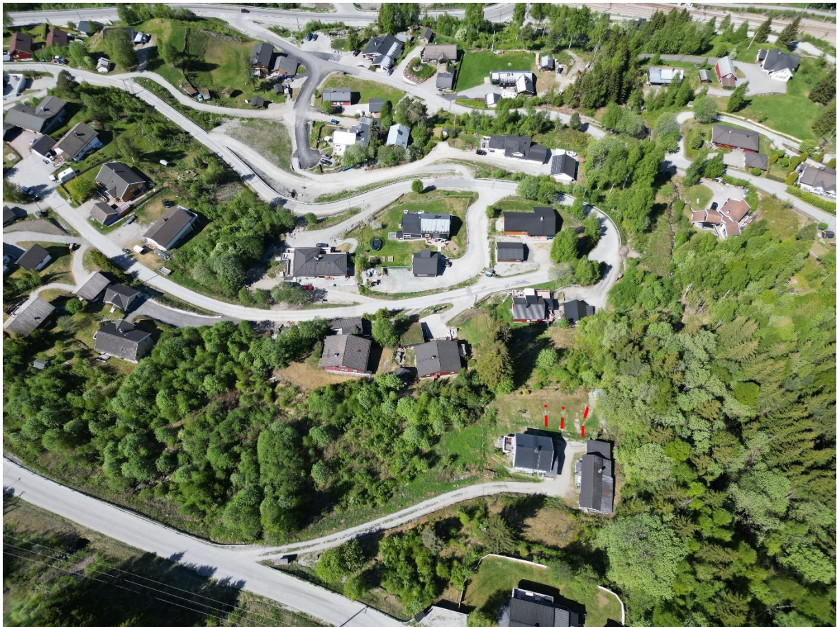
Figur 7: Dronebilde tatt mot nord som viser tegn til vann på avveie i form av erosjonsspor (merket rødt). Dette er merket som infopunkt 12, ved Vestlivegen 17.
