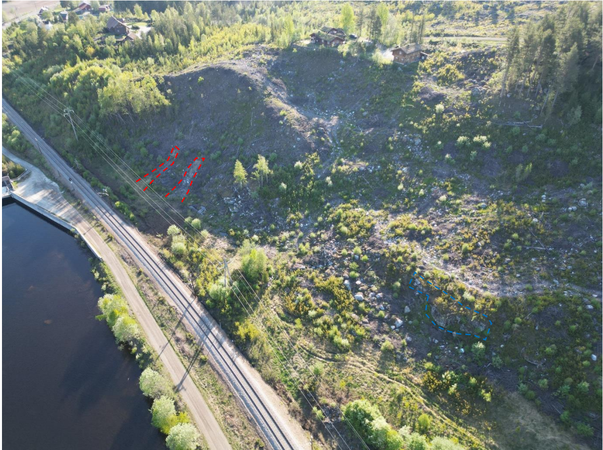
Figur 3: Dronebilde tatt mot sørøst av skråning langs med jernbanesporet vest for Skallehaugen og Ål stasjon. Mindre utglidninger i skråningen er gitt som infopunkt 13, og er merket med rødt omriss. Til høyre i bildet ses små skrenter som er gitt som løснеområde for steinsprang (merket med blått omriss).
