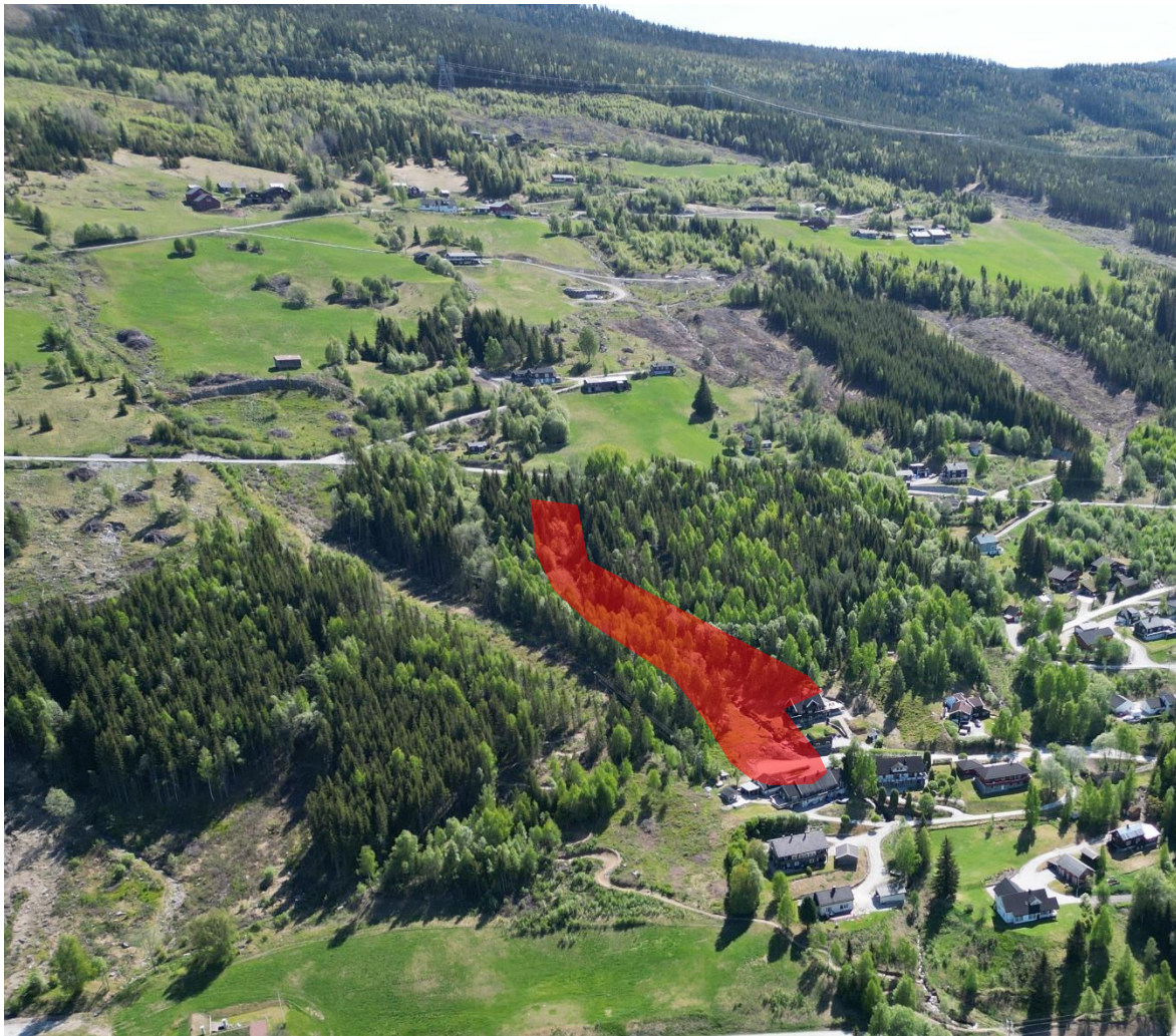
Figur 19: I en situasjon der produktiv skog er tatt vekk vurderer vi at Leirbakken 12 og 13 vil ligge utsatt til for jordskred med årlig sannsynlighet større enn 1/1000. Omtrentlig faresone for jordskred med årlig sannsynlighet større enn 1/1000 der effekt av skog er sett vekk ifra er inntegnet med rødt.
