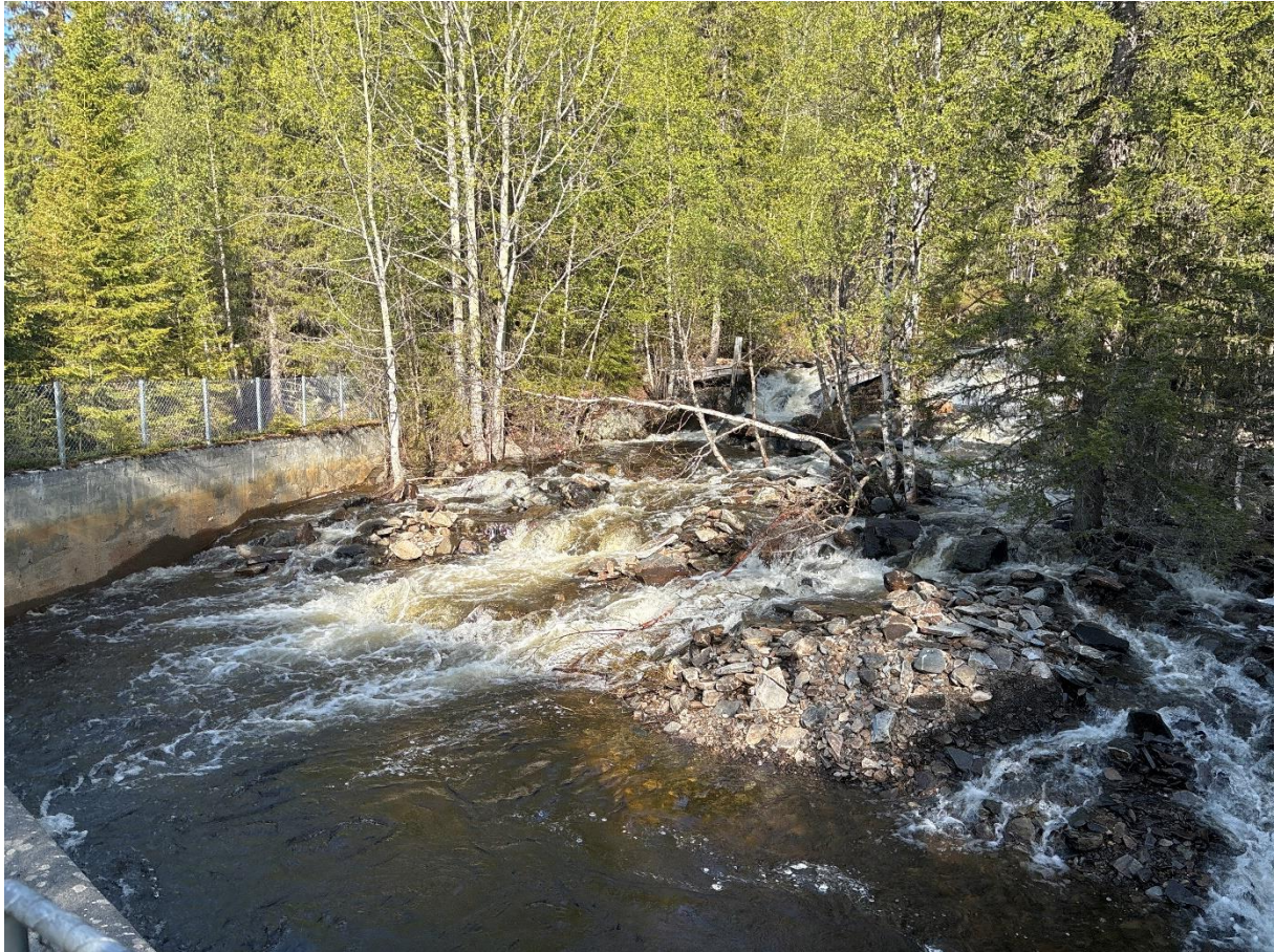
Figur 5: Bildet ser mot øst, ved dammen, kote + 612. Større mengder med relativt grove løsmasser har blitt avsatt. Trolig som følge av erosjon og massetransport i nyere tid.
