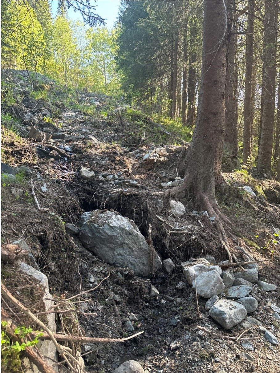
Figur 14: Erosjon og massetransport i forbindelse med høyere vannføring enn normalt i bekkeløpet. Lateral spredning er opp mot 15 m fra eksisterende bekkeløp. Bildet er tatt på kote + 534.
