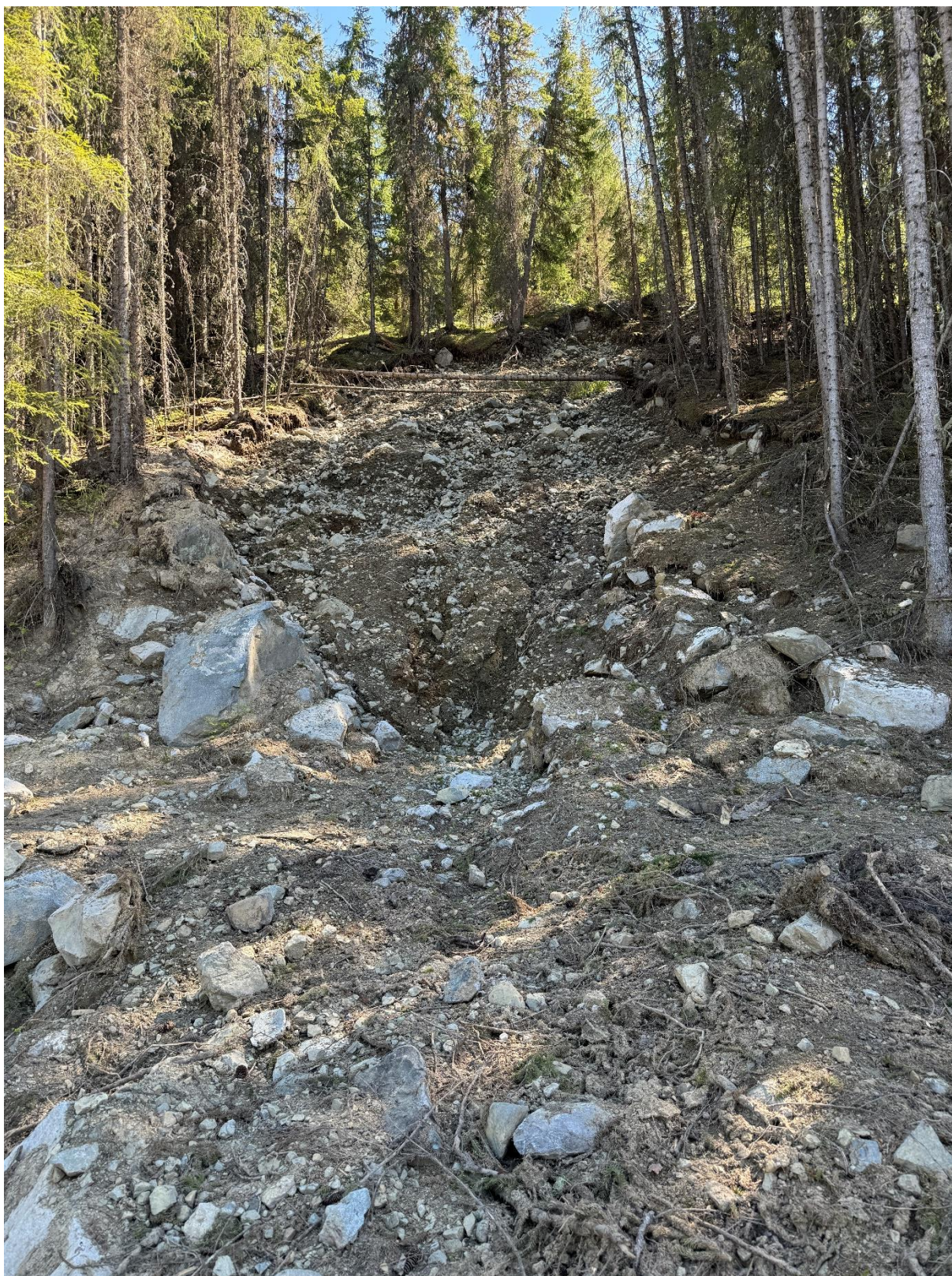
Figur 3: Nærbilde av skredet. Skredmassene er usorterte, med både finere og grovt materiale med blokker opp mot 1m 3 .
