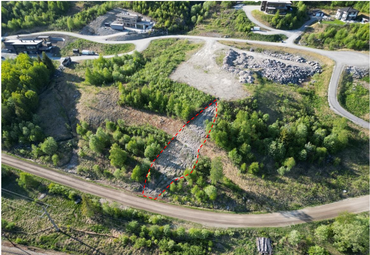
Figur 1: Jordskred ned på strandalivegen fra Embrikshaugen (merket med stiplet rød linje). Utløst under ekstremværet "Hans", 08.08.2023. Gikk delvis ned på veg, men stengte ikke veg. Skred nr. 4. Bilde ser mot sør, og er tatt med drone.
