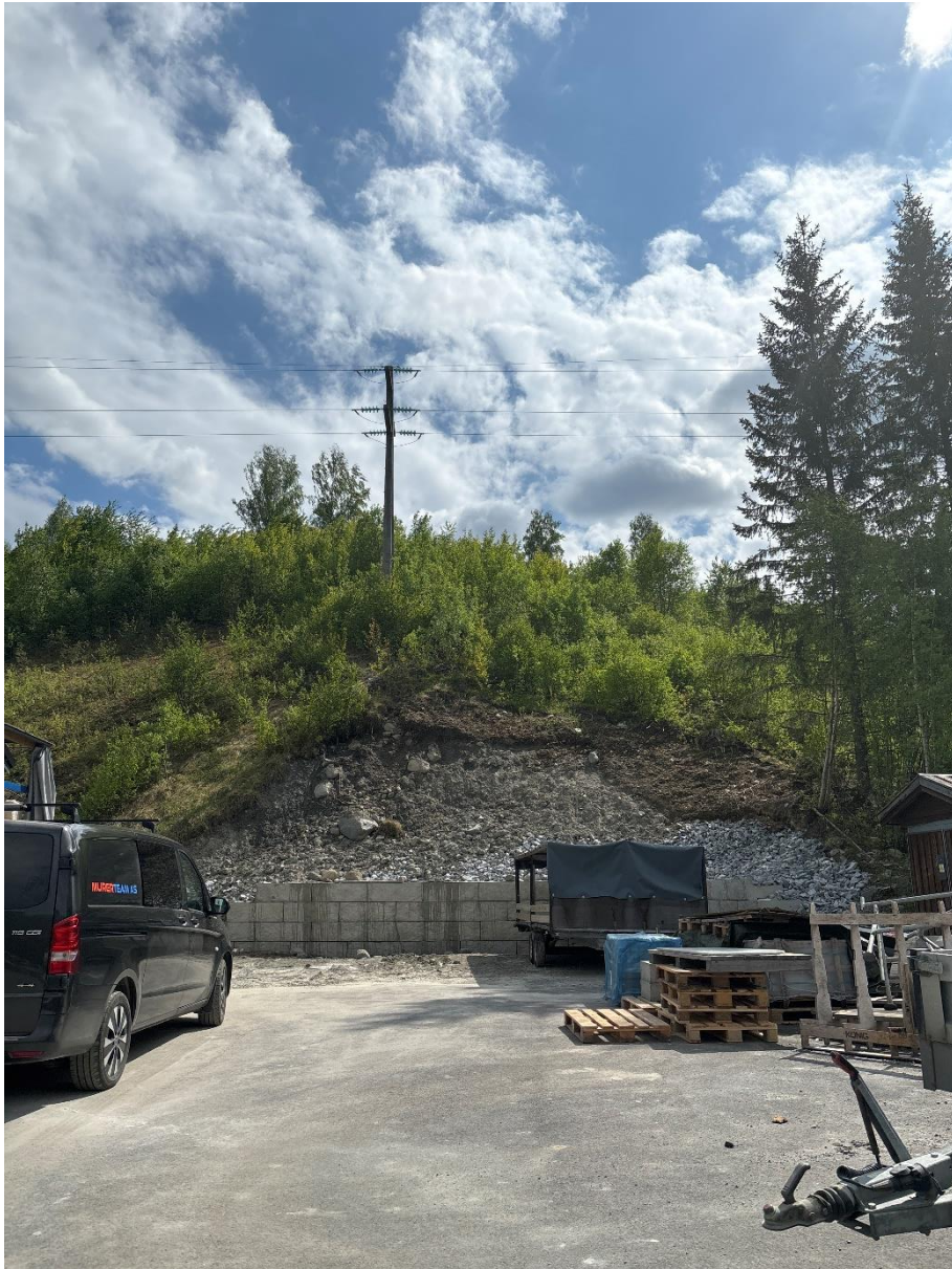
Figur 6: Infopunkt 7, utglidning av løsmasser i brattere skråning, sør for Sutøyvegen 11. Vi vurderer at en utglidning av et slikt volum har lavt skadepotensiale og det er derfor ikke inntegnet faresone her. I kartleggingsområdet er det observert flere slike mindre utglidninger. Bildet er tatt mot sør.
