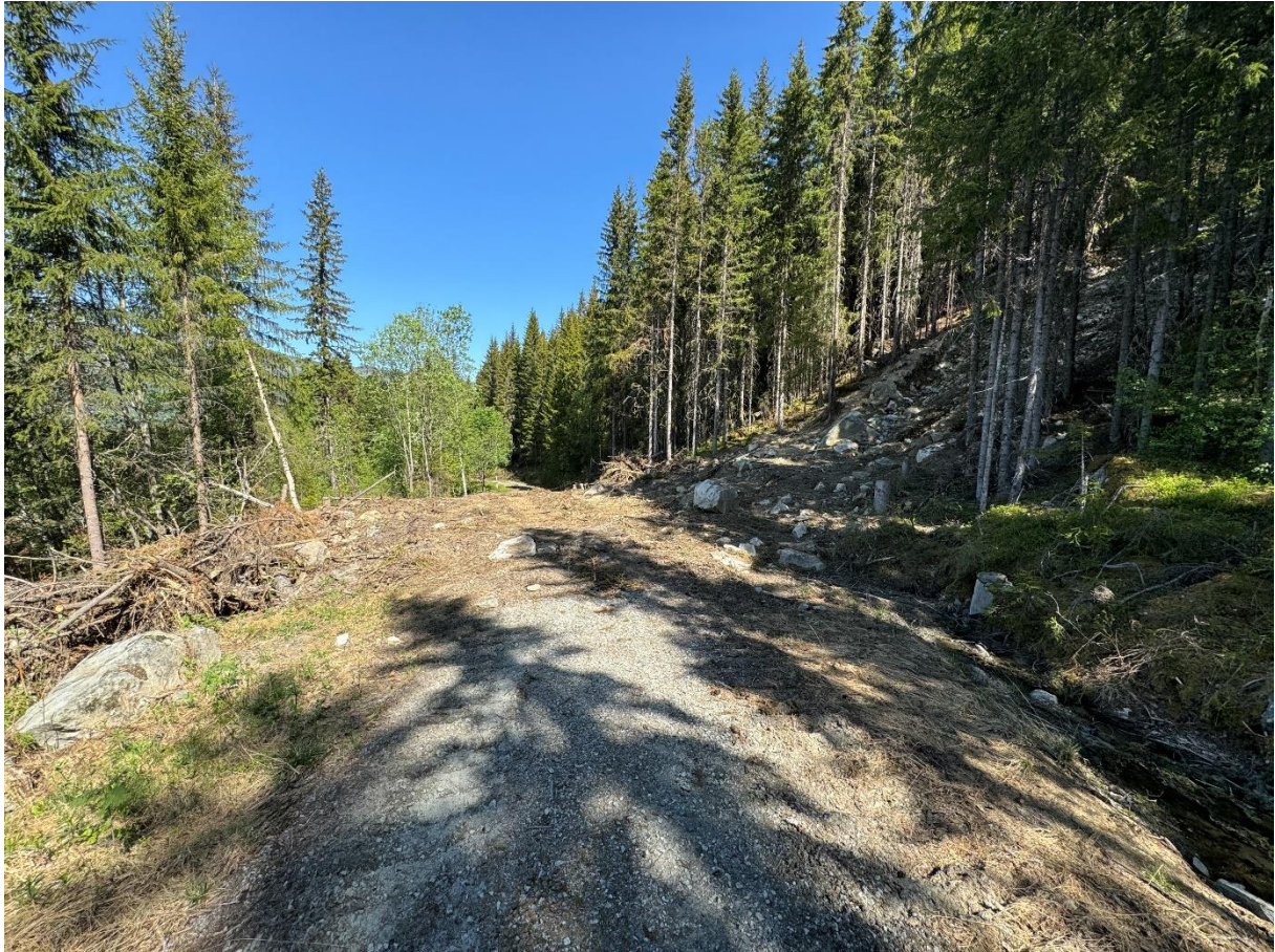
Figur 4: Skredet (nr. 1) krysset vegen. Usikker på om vegen har blitt ryddet for skredmasser. Nedside veg lå det skredmasser 2-3m fra vegen. Bildet er tatt mot øst.
