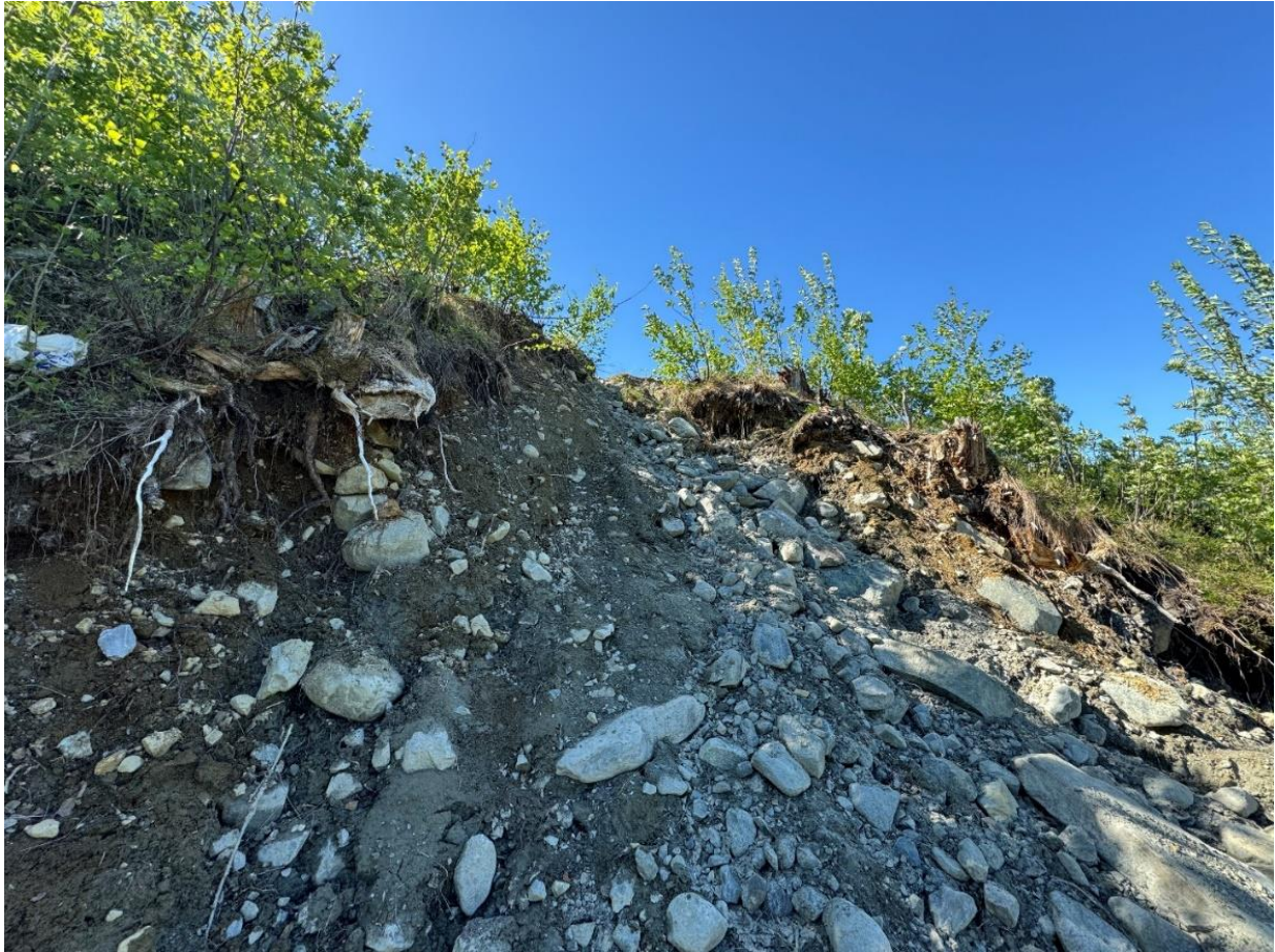
Figur 2: Bilde av øvre del av løснеområdet til skredet vist i Figur 1. Bruddhøyden er omtrent 0,5 m. Utløste skredmasser er usorterte og avrundet, noe som tyder på morenemasser. I tillegg ble vegetasjonslag og humuslag utløst. Bildet er tatt mot sørvest.
