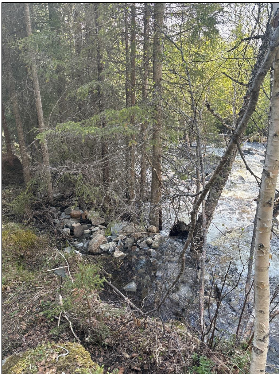
Figur 3: Stedvis er det mindre overløp, også med avsetninger. Bildet ser ned løpet, mot dammen, fra kote + 615.
