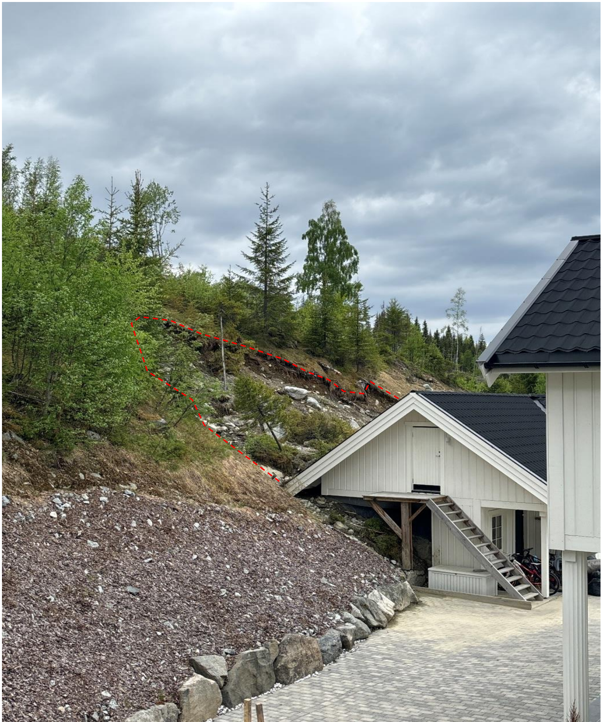
Figur 4: Utglidning av løsmasser (merket med rødt omriss) bak garasje ved Øvre Kolbotn 27, infopunkt 3. Vi vurderer at en utglidning av et slikt volum har lavt skadepotensiale og det er derfor ikke inntegnet faresone her. I kartleggingsområdet er det observert flere slike mindre utglidninger. Bildet er tatt mot sørvest.
