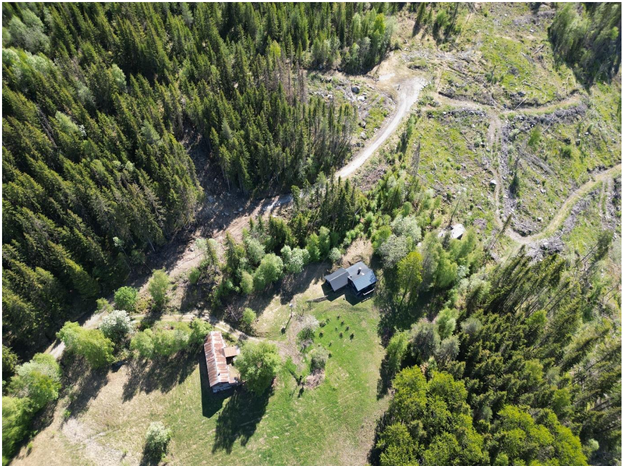
Figur 7: Øvre bebyggelse i kartleggingsområdet. Ved fjerning av produktiv skog vil bygg til venstre i bilde være utsatt for jordskred fra overliggende skråning med årlig sannsynlighet større enn 1/1000.
