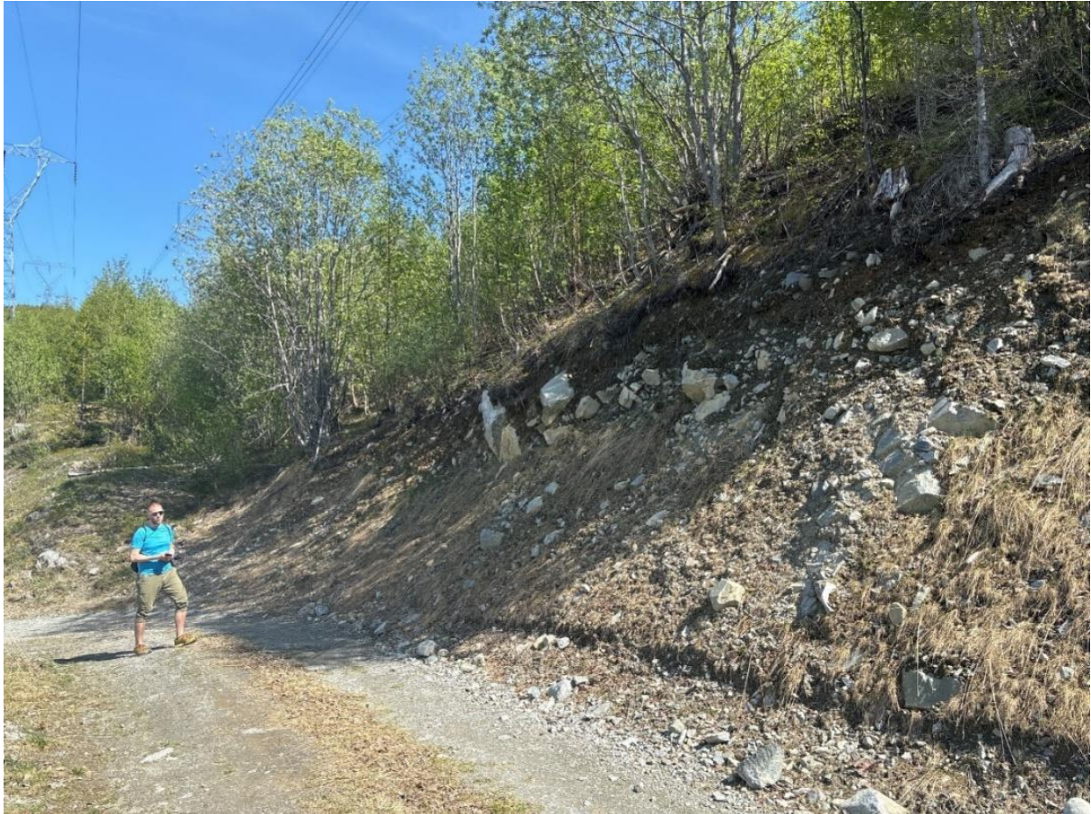
Figur 10: Skråning sør for Vestlivegen der løsmasser nylig har rast ut. Infopunkt 9. Her er det inntegnet faresone jordskred som følge av en viss høyde på skråningen. Bildet ser mot sørøst.
