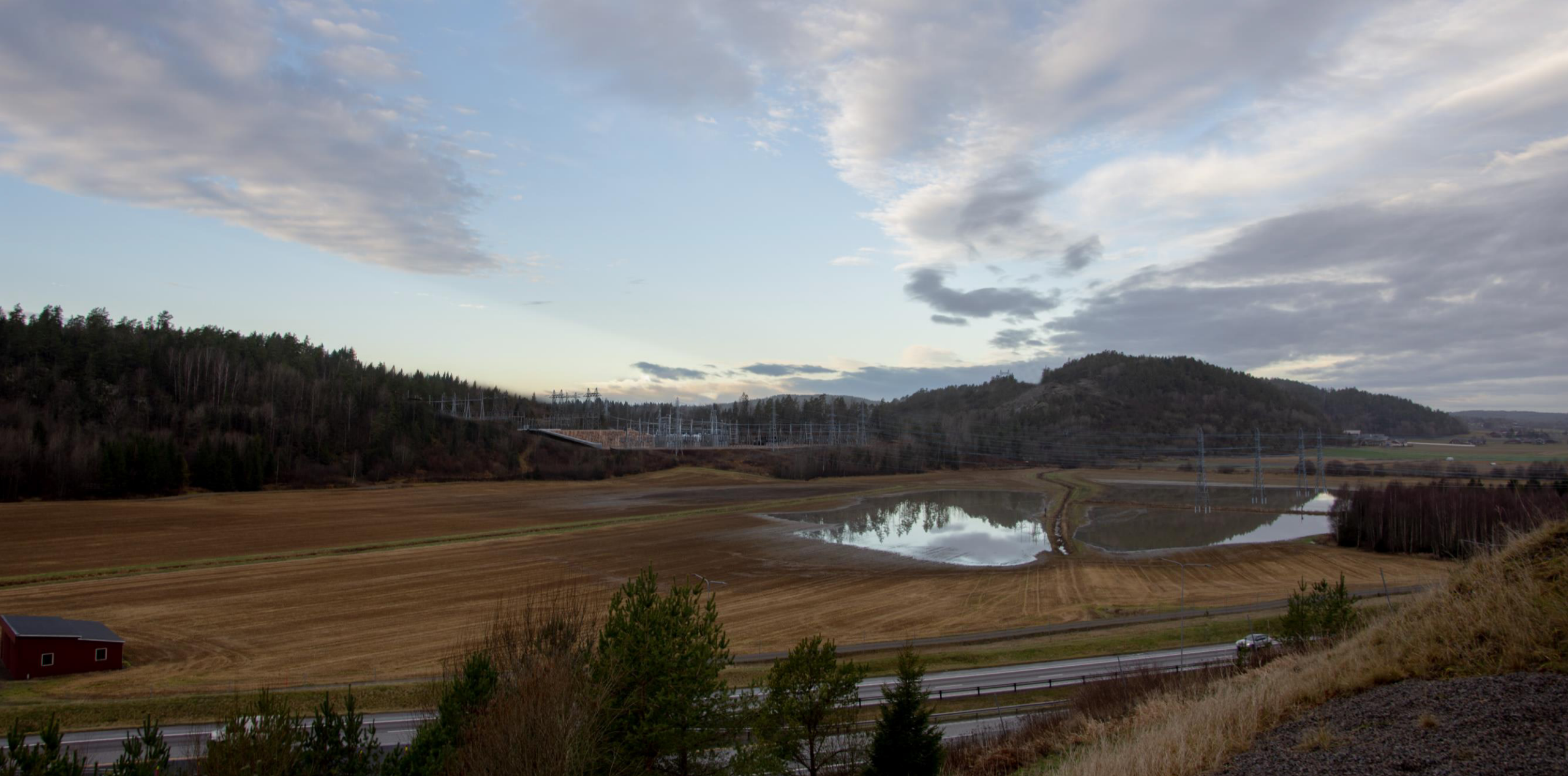
2) Vestre Ekeberg 12 med transformatorstasjoner
