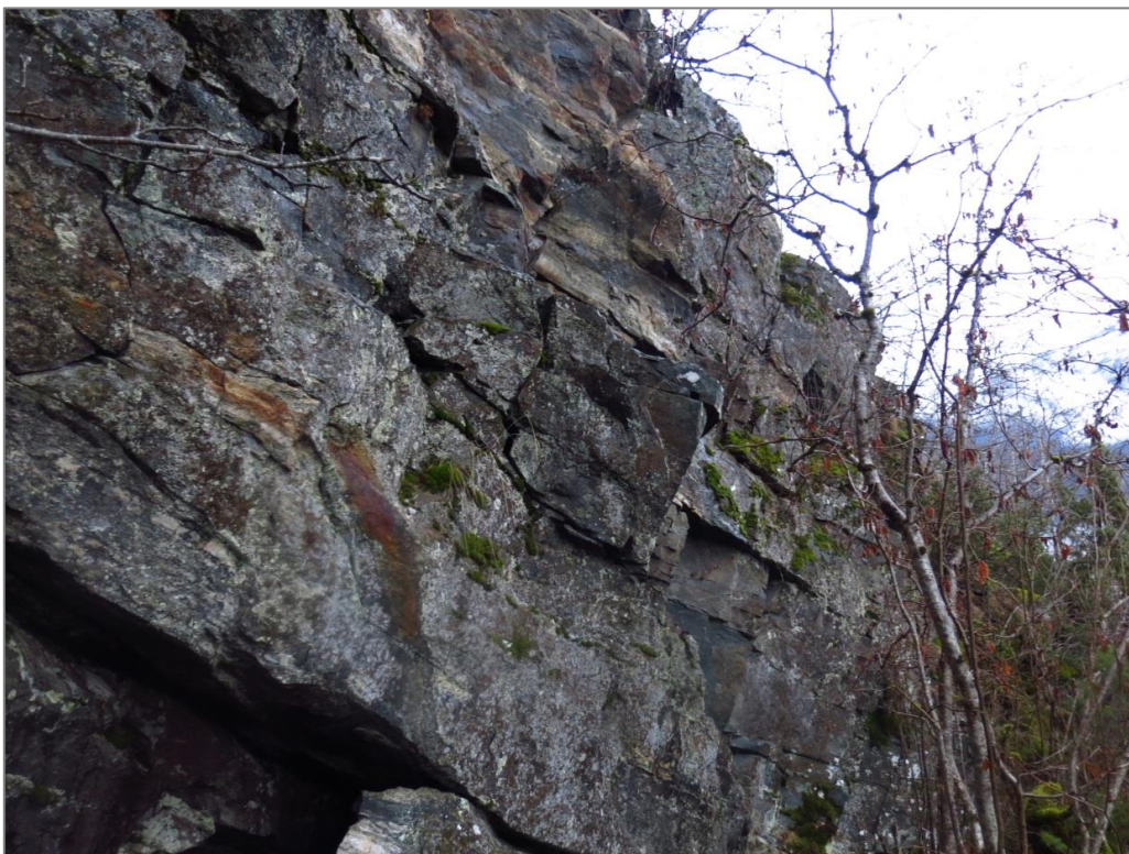
Bilde 21. Flere godt oppsprukket bergpartier finnes langs ca. samme høyde hele veien mot øst (nord fra Leite). Bildet er tatt mot øst, et par hundre meter lenger øst for bergparti på bilde 14-20. Bergparti B på helningskart (vedlegg A).
