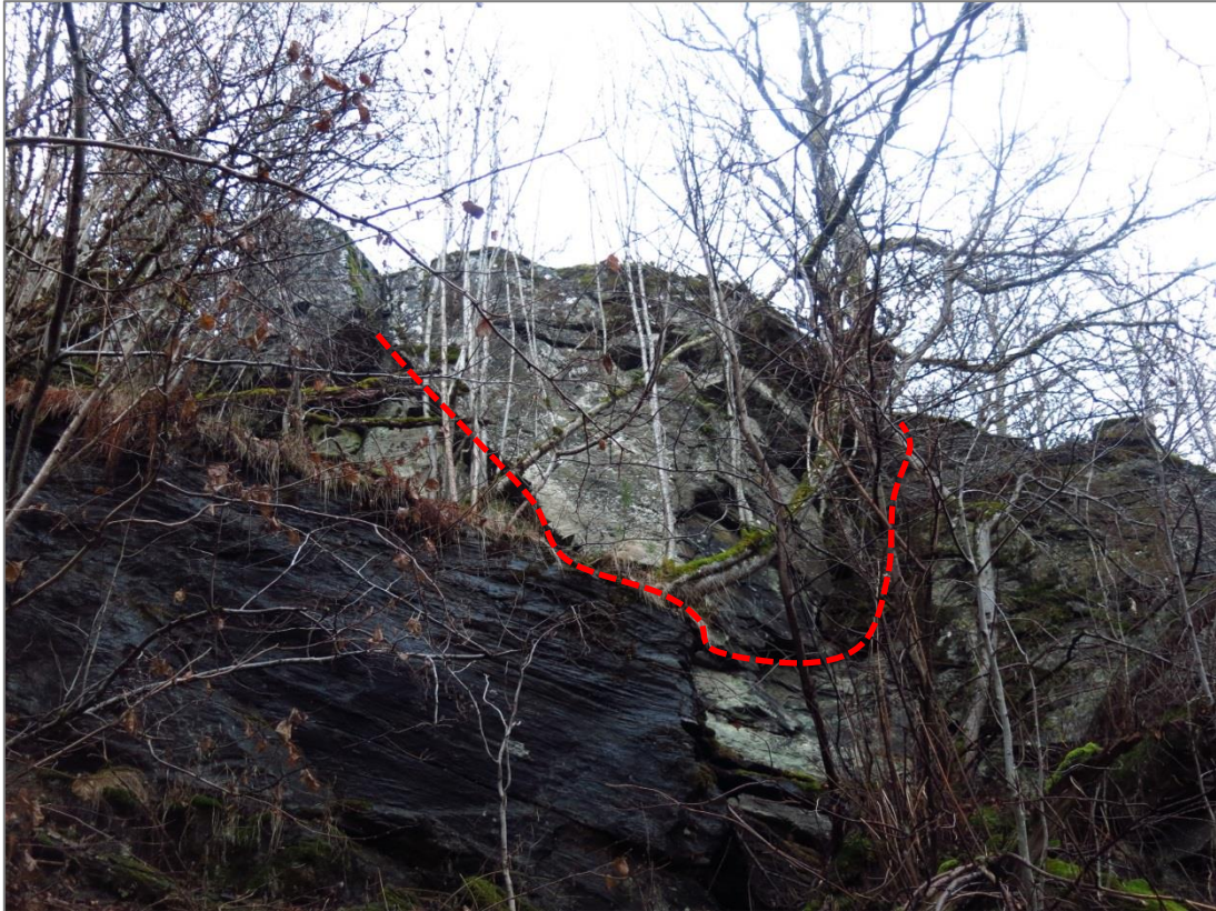
Bilde 14. Truende bergparti med fall mot planområdet og store sprekker i bakkant, ca. 220 moh. rett nord for Åbergevegen 36-38. Størrelsen av denne blokken er ca. 100 m 3 .
