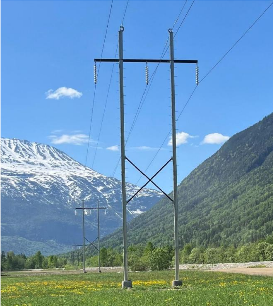
Figur 2-9. Avbildet mast med ueloksert aluminium, samt kryss og traverser i eloksert aluminium. Her ser en tydelig forskjell på de to ulike fargevariantene av aluminium. Bildet: AluMast System
