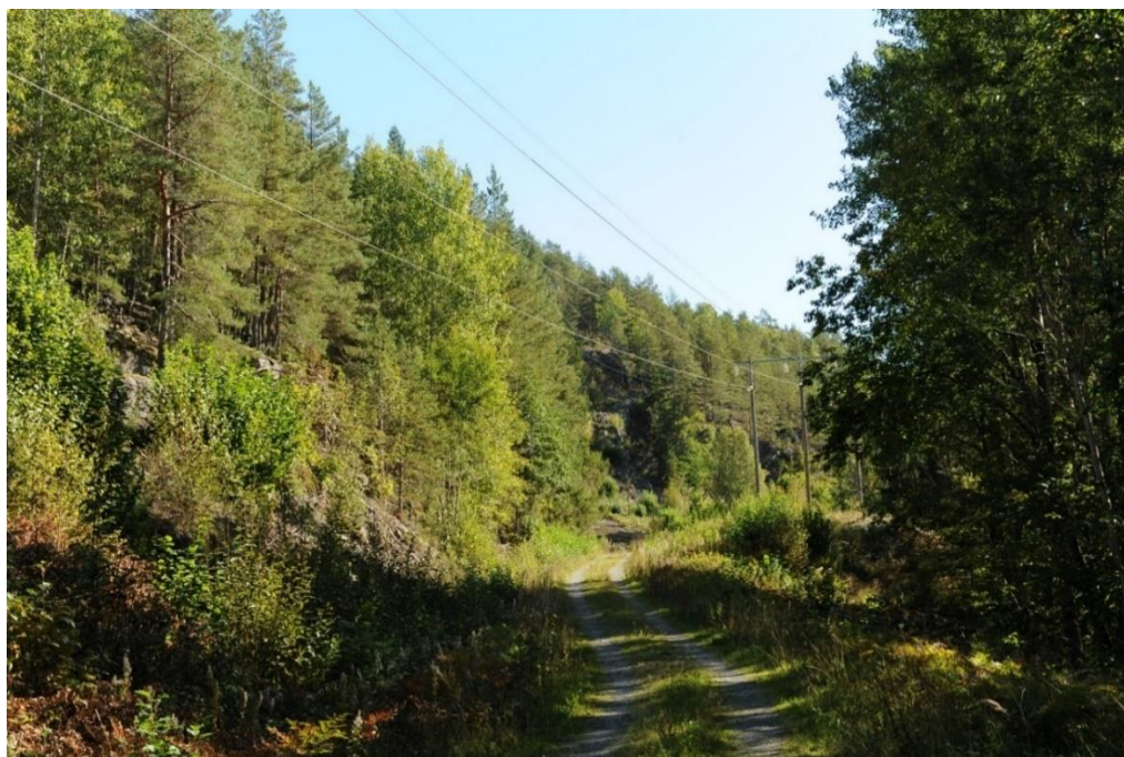
Figur 7-35. Eksisterende 66 kV ledning passerer Skaravegen ved flere steder, her er veien avbildet i det man kommer opp fra Eidsfoss sluser. Her vil ny trasé gå lenger inn i skogholtet til venstre på bildet, slik at den blir mindre synlig fra veien.
