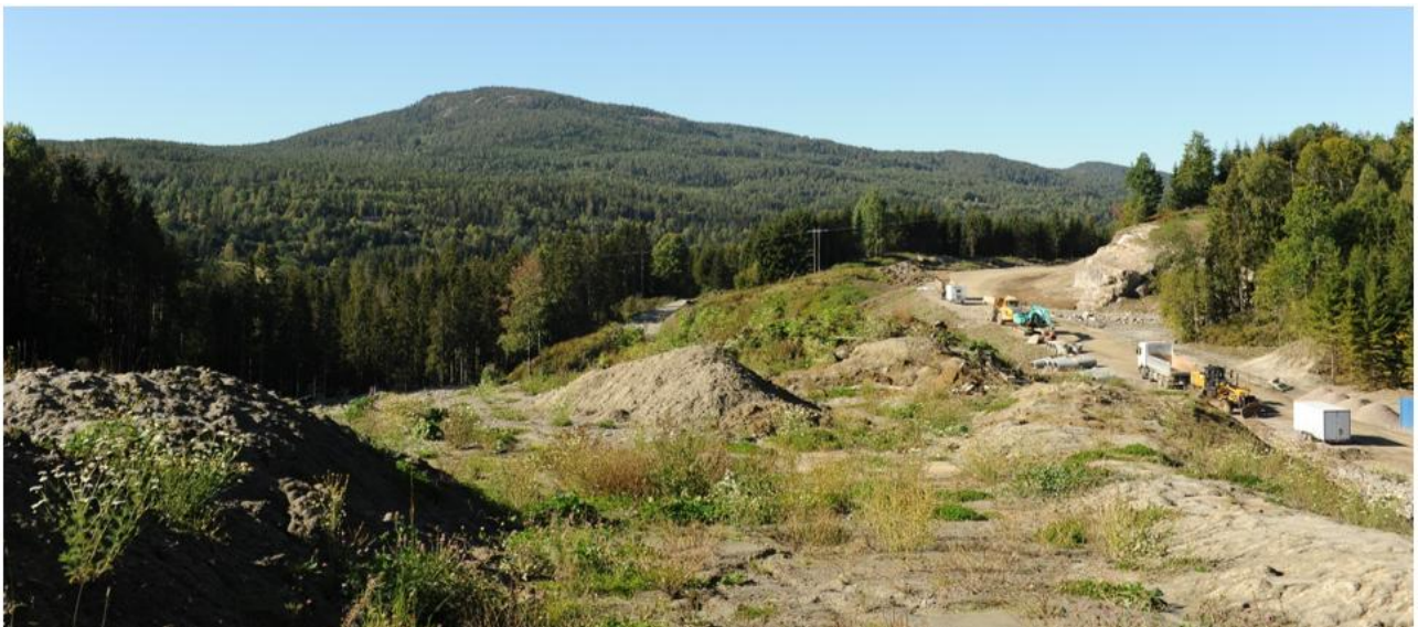
Figur 7-10. Anleggelse av nye Fv. 359 gjennom delområdet.
