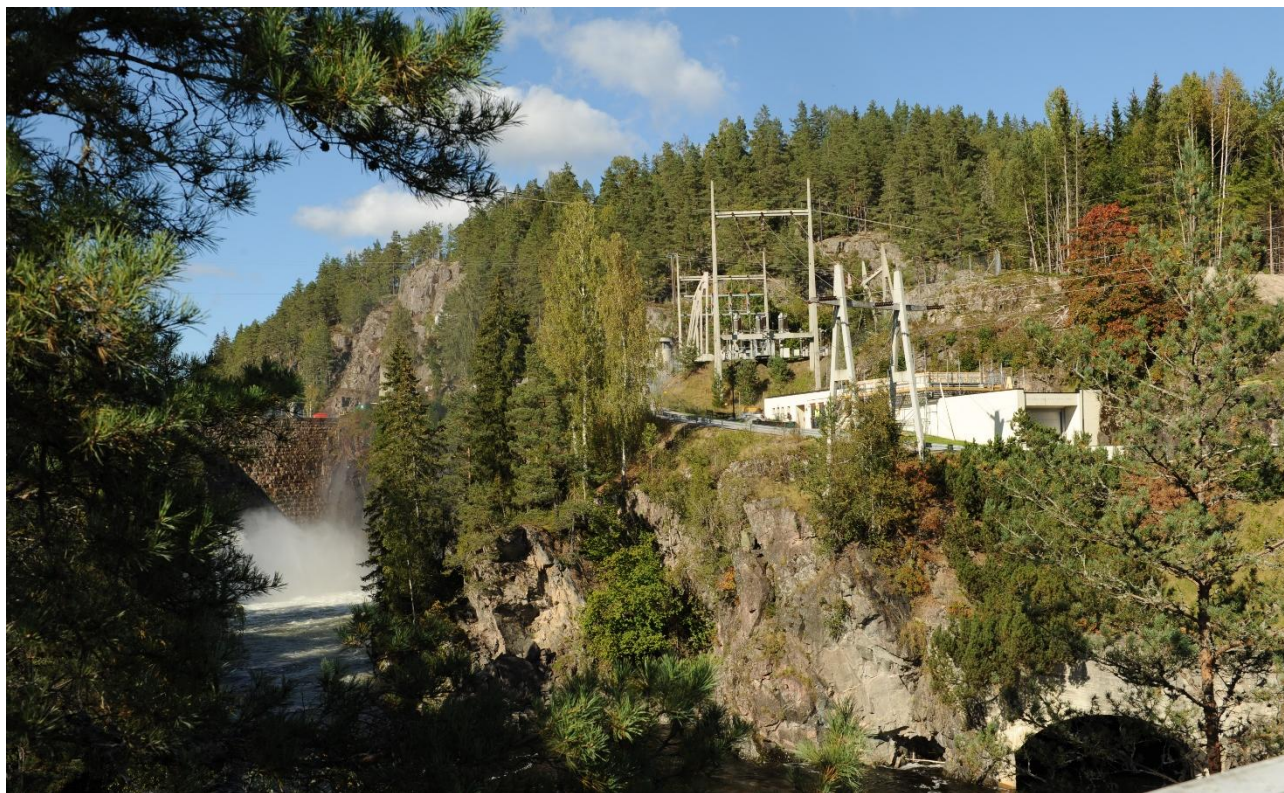
Figur 7-6. Bildet er tatt fra brua ved Vrangfossvegen, og viser Vrangfoss til venstre og Vrangfoss kraftverk til høyre.
