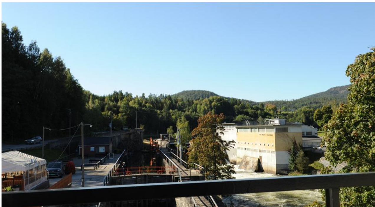
Figur 7-11. Slusene ved Ulefoss kraftverk. I bakgrunnen ser man Austre Nuke (t.v.) og Stangefjell (t.h.), som er skogkledde åser og typisk for området. Bildet er tatt på befaring september 2024.
