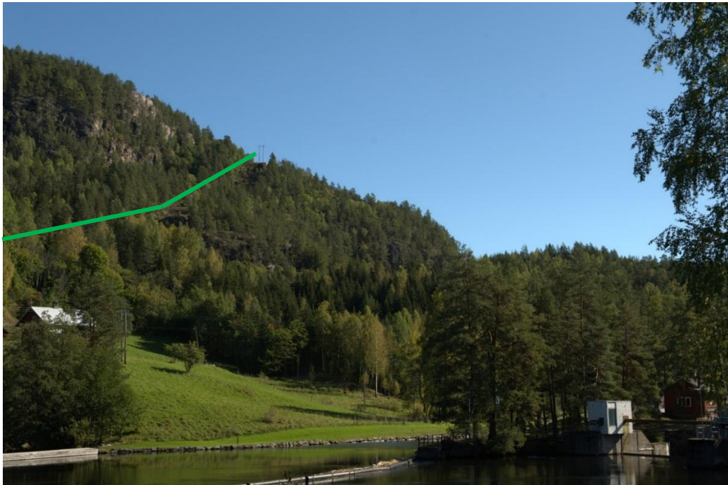
Figur 2-6. Eksisterende 66 kV ledning er plassert i ulendt terreng i åssiden. Den er skissert inn med en grønn strek.
