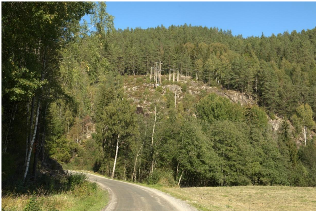
Figur 2-11. Eksisterende bryteranlegg ved Kåsa, plassert i en skråning.
