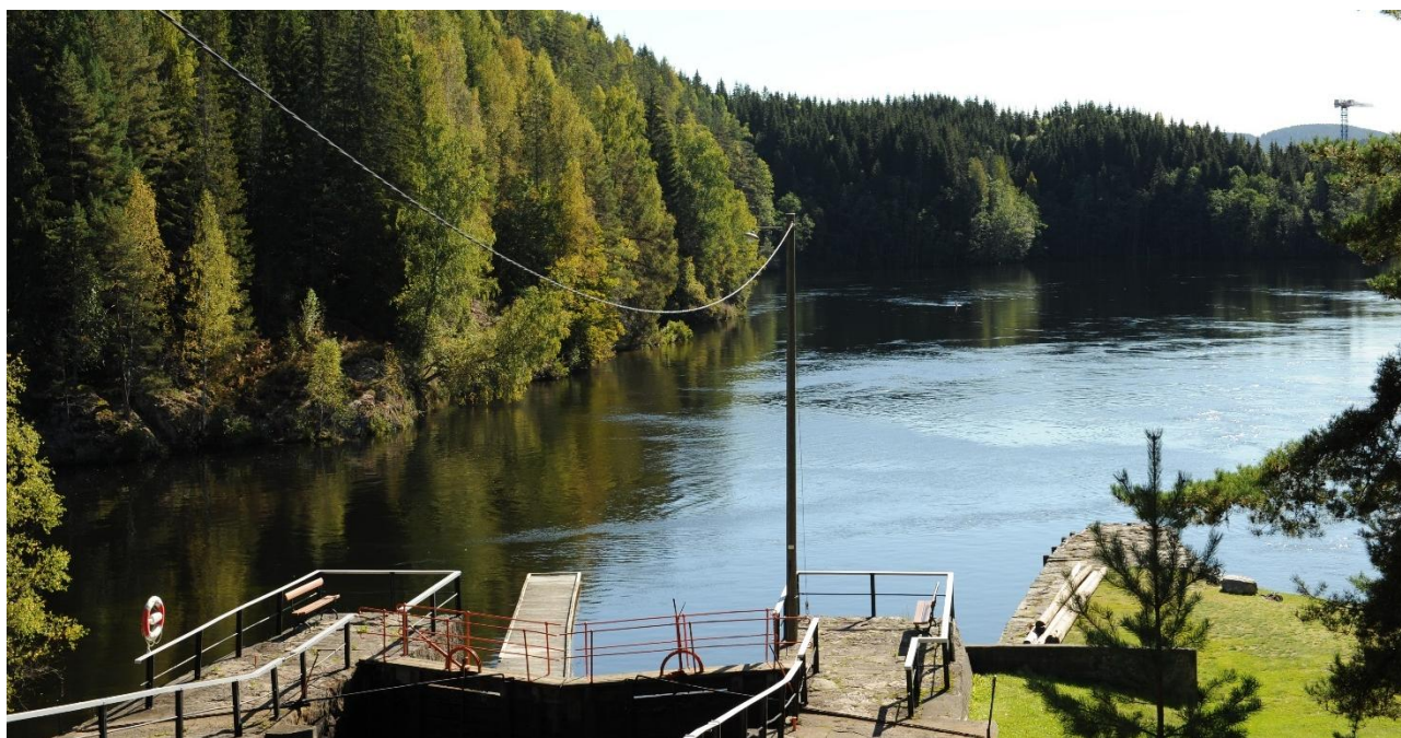
Figur 7-8. Slusene ved Eidsfoss kraftverk.
