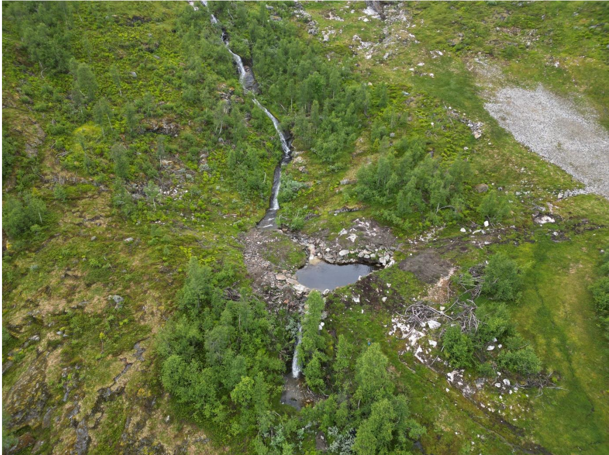
Figur 3-9: Dronefoto som viser den kunstig oppdemte dammen, IP16)
