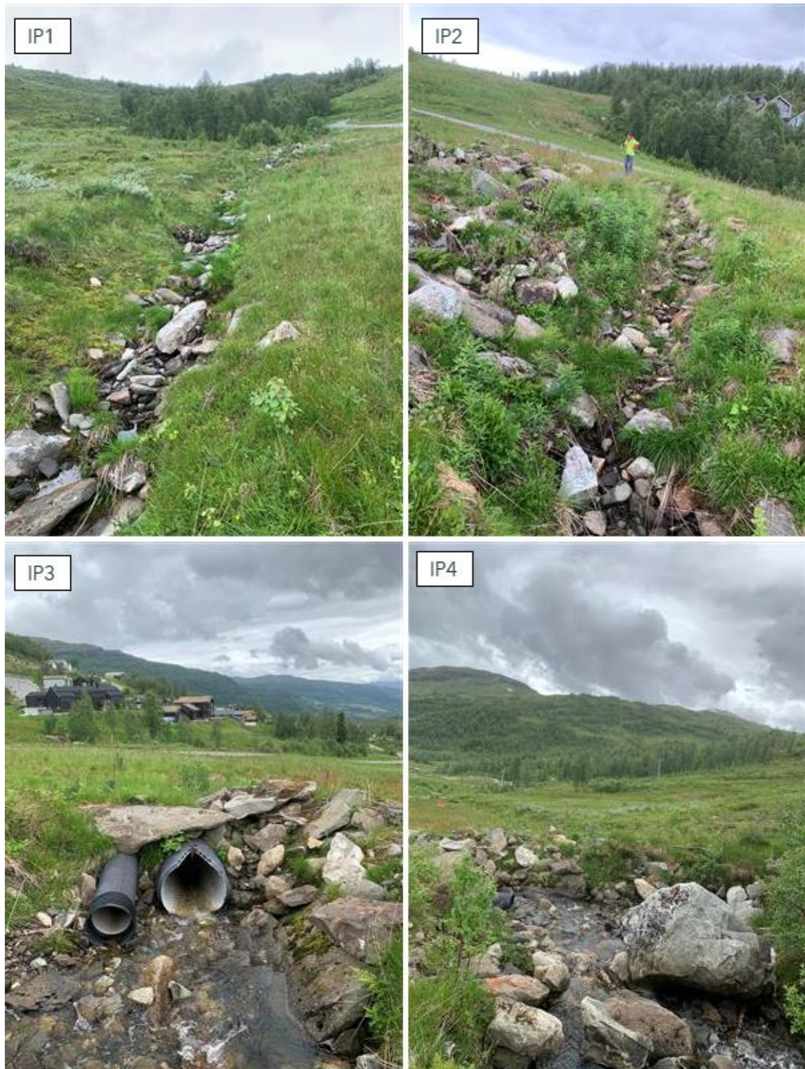
Figur 3-12: Bilder som viser bekken idet den når kartleggingsområdet. Mesteparten av vannet fortsetter i rør vestover (IP 3 og 4). Deler av bekken tar også en krapp sving østover før den fortsetter sør (IP 1 og 2)
