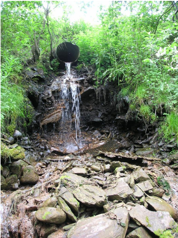
Bilde 18: Sunndalsbekkens i rør. Øvre ende for sikringstiltak i bekken
