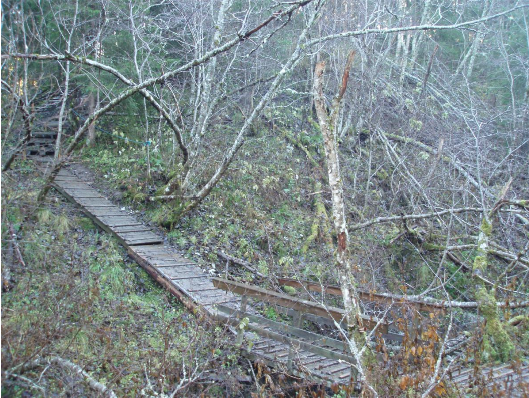
Bilde 4: Trebru over Sunndalsbekken ca ved P550
