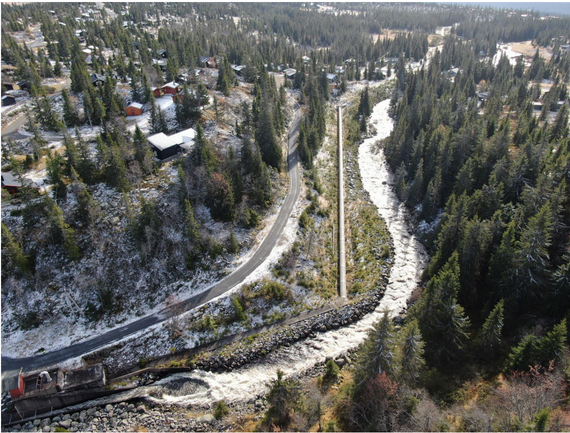
Bilde 2: Oversiktsbilde adkomstvei.
