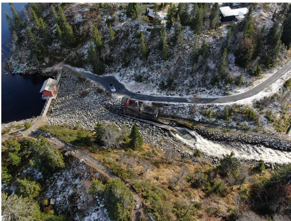
Bilde 1: Oversiktsbilde over tiltaksområdet ved dam Sjusjøen.
