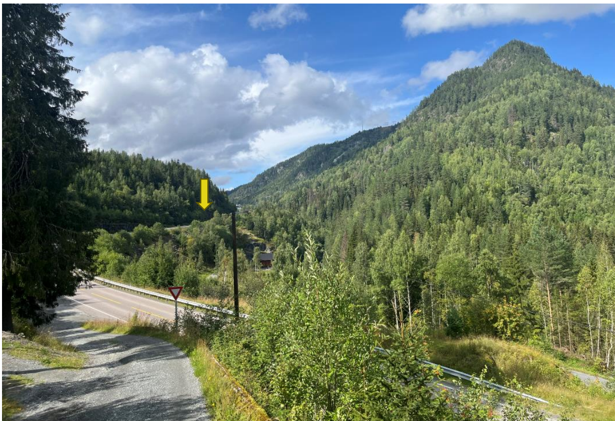
Figur 6. Påhuggsområdet sett fra bebyggelsen på sørsiden av fv. 40. Eksisterende Rødberg kraftverk kan skimtes i midten av bildet. Det vil bli behov for en del skogrydding og bredere vei.
