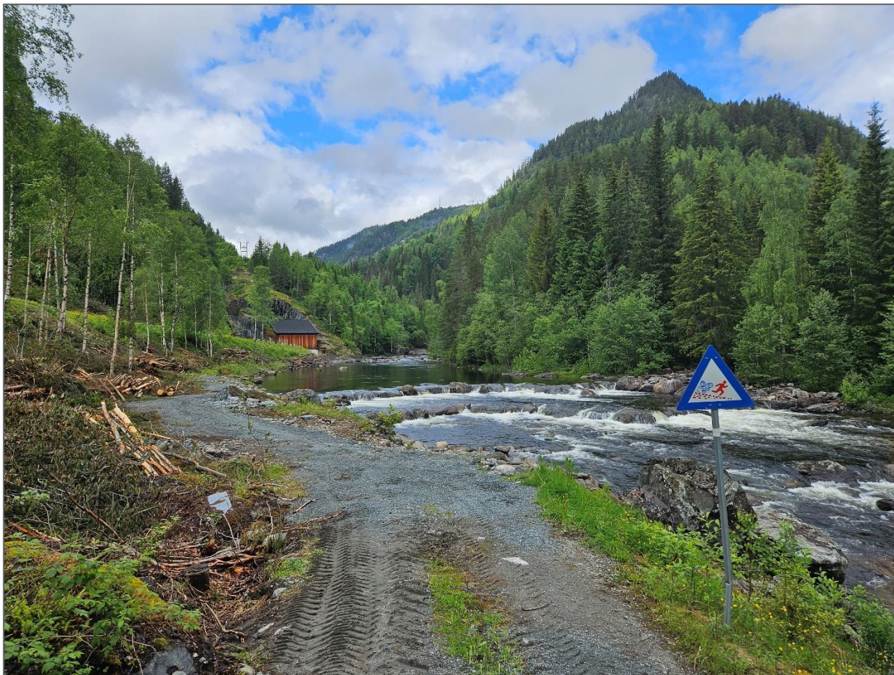
Figur 4. Kulp og fiskeplass ved Rødberg kraftverk. Foto tatt mot vest. Påhugg for adkomstalternativ B er planlagt til venstre for kraftverket, bak bjørkene i venstre bildekant.
