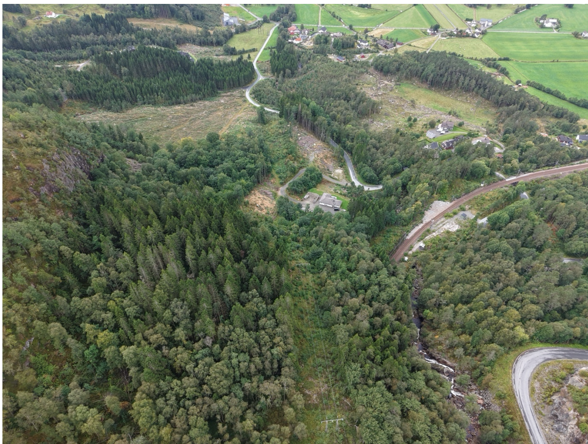
Figur 40: Dronebilde tatt oppstrøms fossen, ned mot kraftstasjonsområdet
