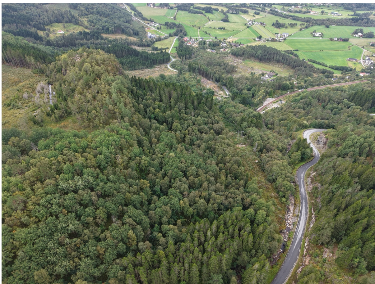
Figur 2: Oversiktsbilde. Viser terrenget noe nedenfor inntaksområdet, ned mot kraftstasjonsområdet
