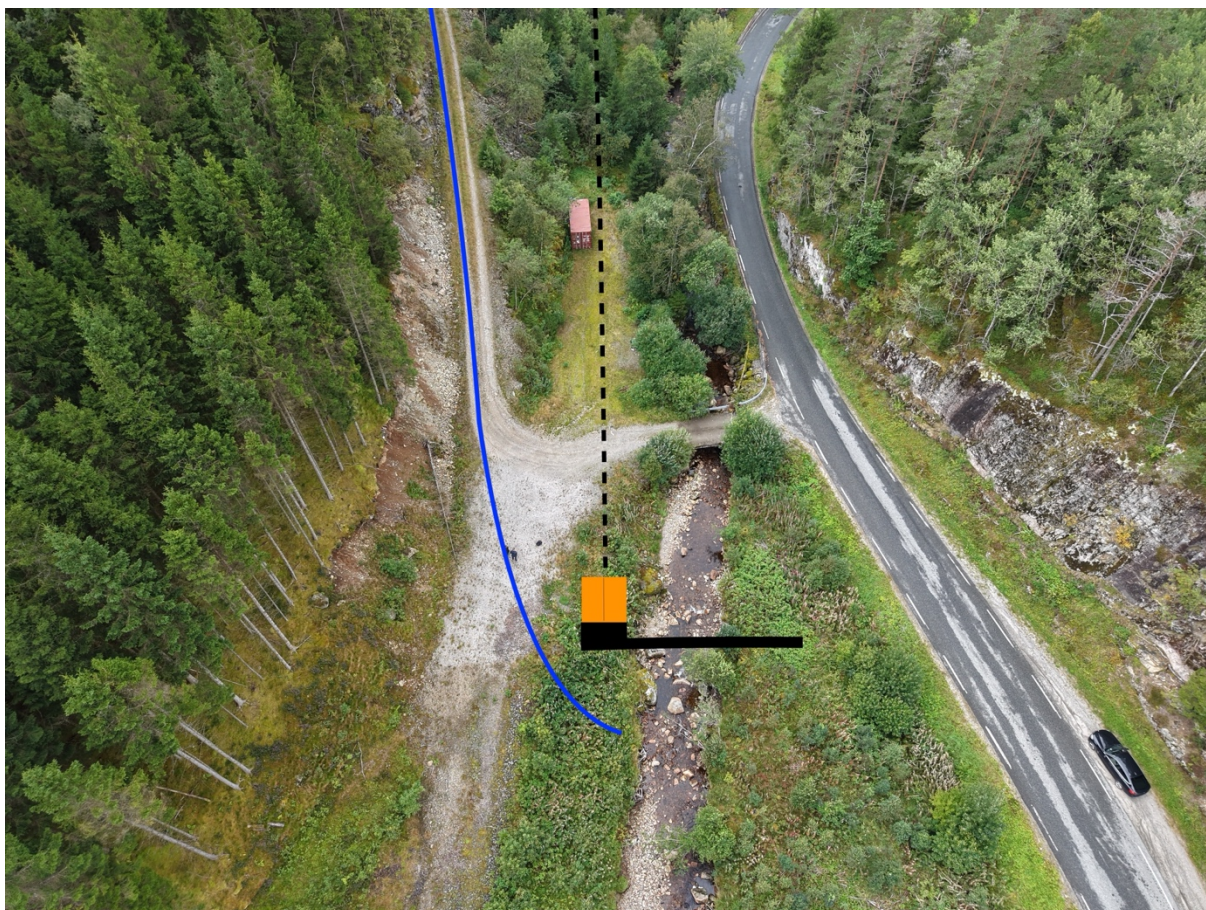
Figur 12: Rørgate føres ut på sørsiden av elva
