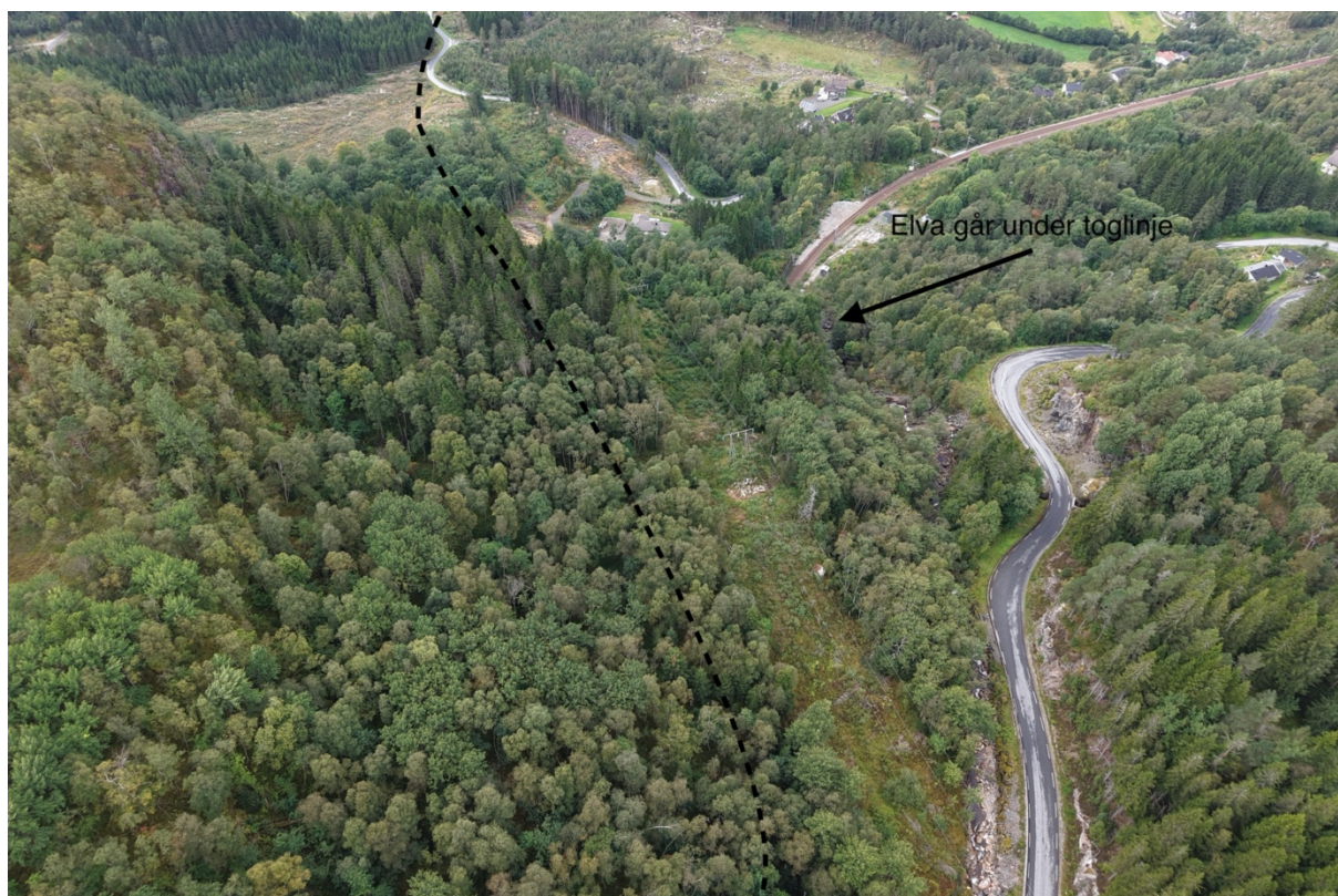
Figur 14: Legges sør for høyspentlinje
