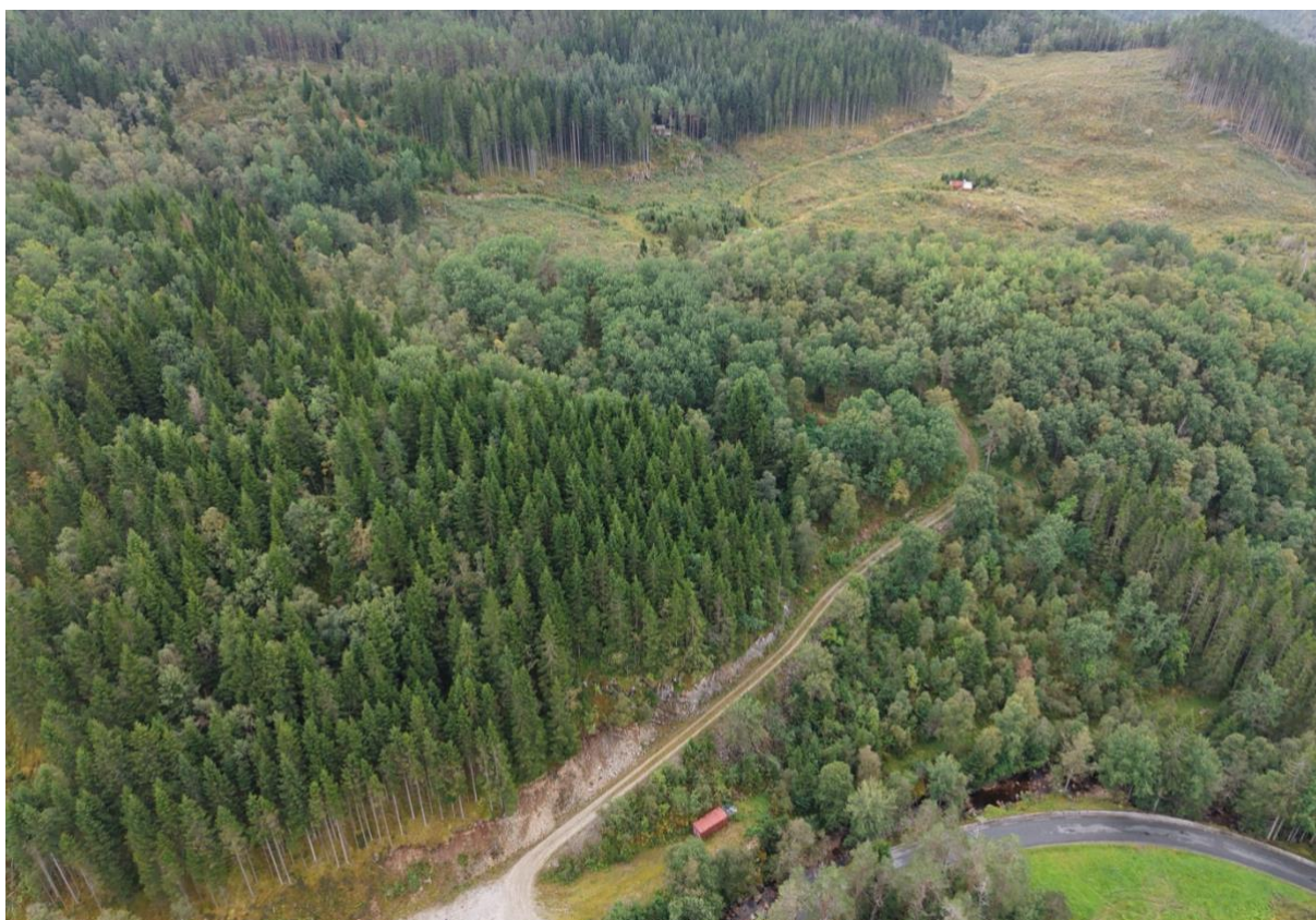
Figur 2: Bilde tatt mot overføringen
