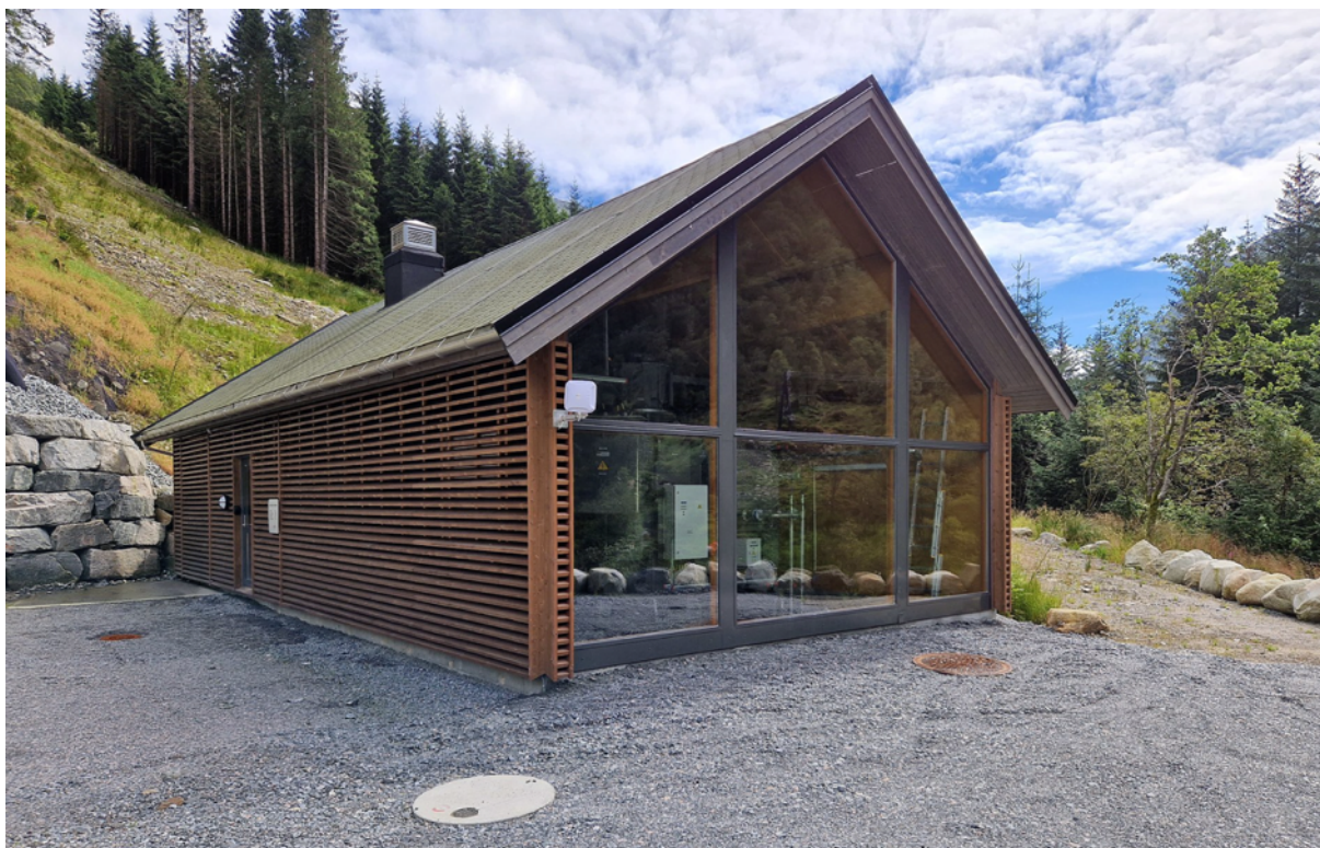
Bilde 8: Eksempel på kraftstasjon. Foto viser Duvedalen kraftverk
