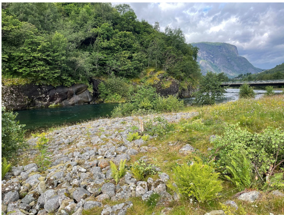
Figur 4: Fra elvebredden rett oppstrøms Nyheim bru. Grove masser, delvis også aktivt erosjonssikret.
