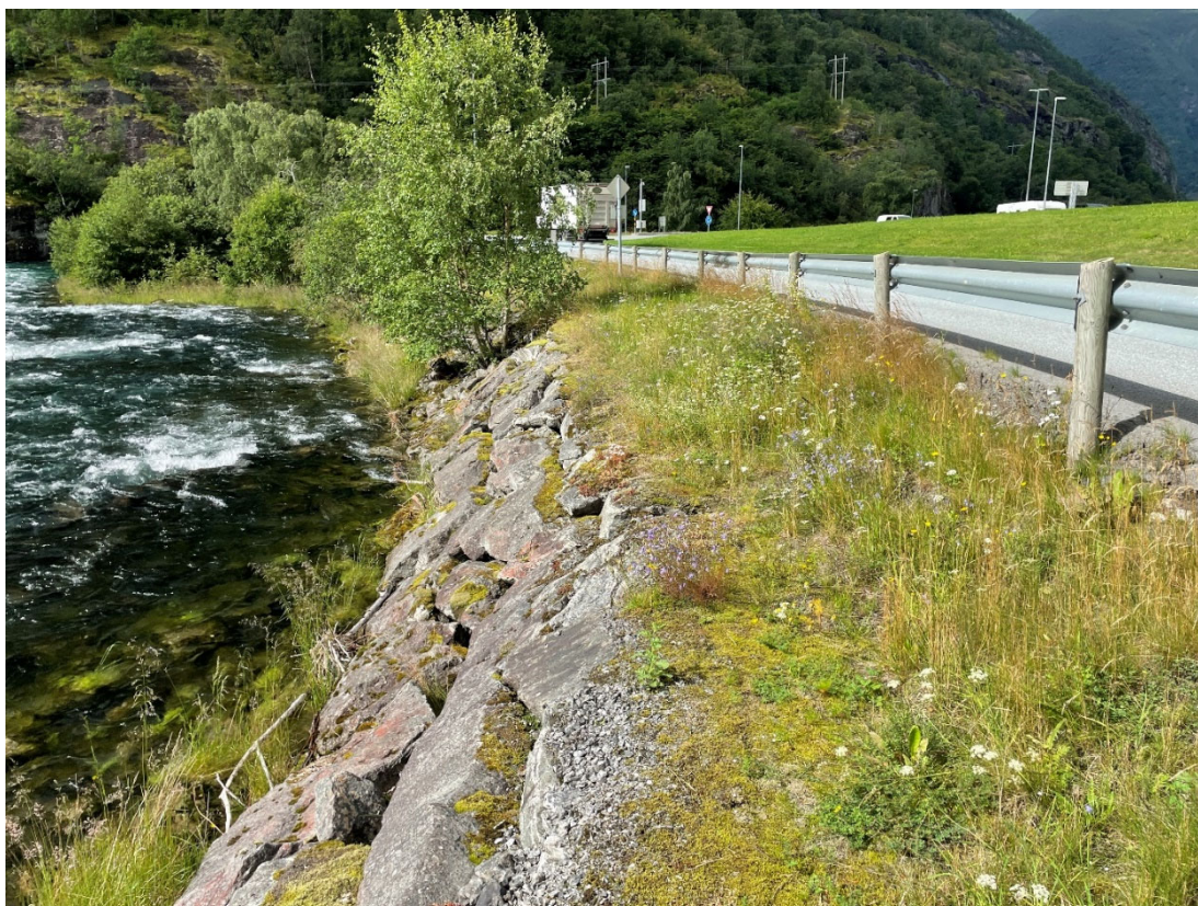
Figur 3: Eksisterende elvekant sør for Fv50 i nedkant av det aktuelle løснеområdet
