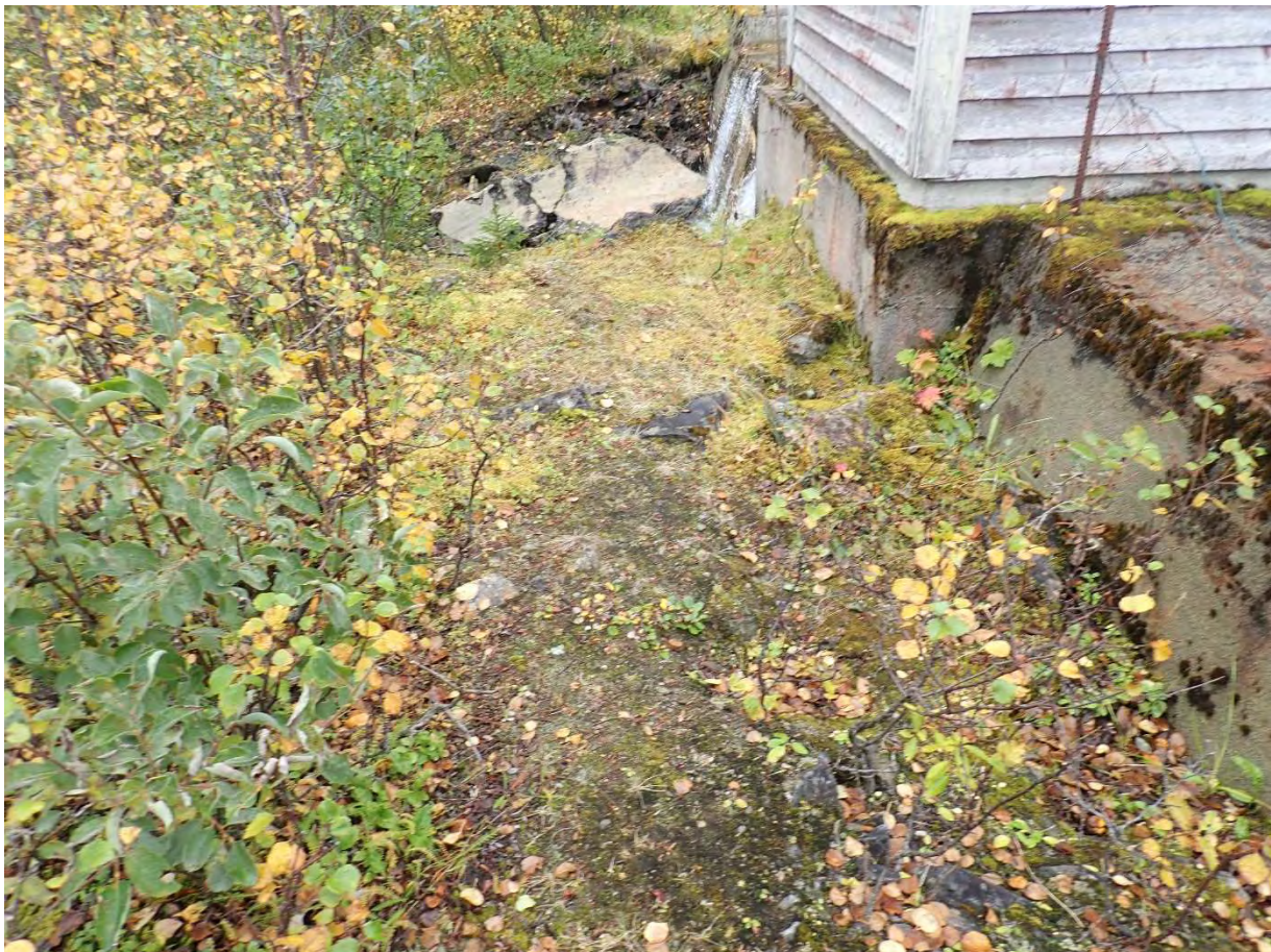
Figur 19. Støttefylling nedstrøms ventilhus.
