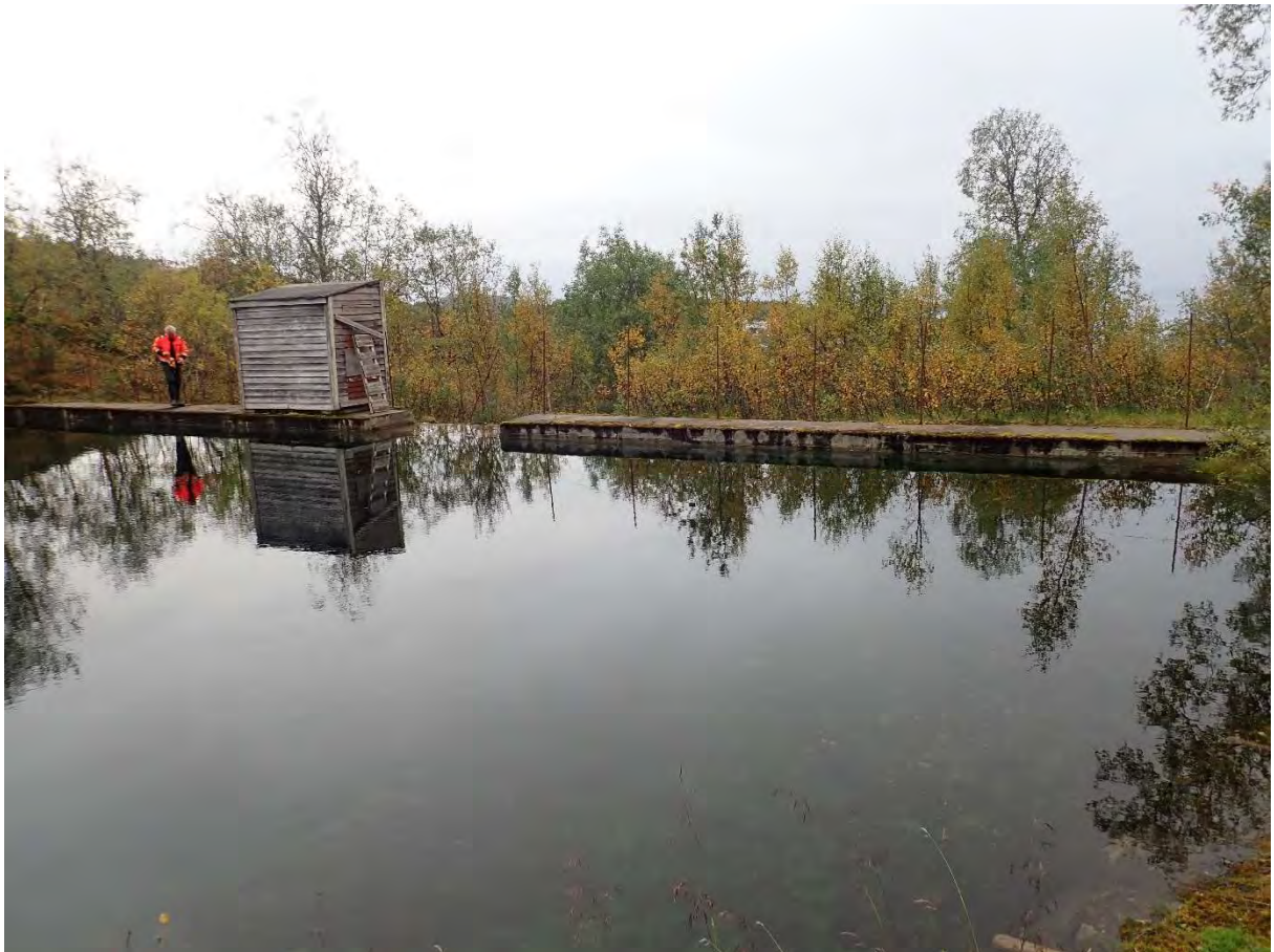
Figur 11. Dam, overløp og ventilhus.
