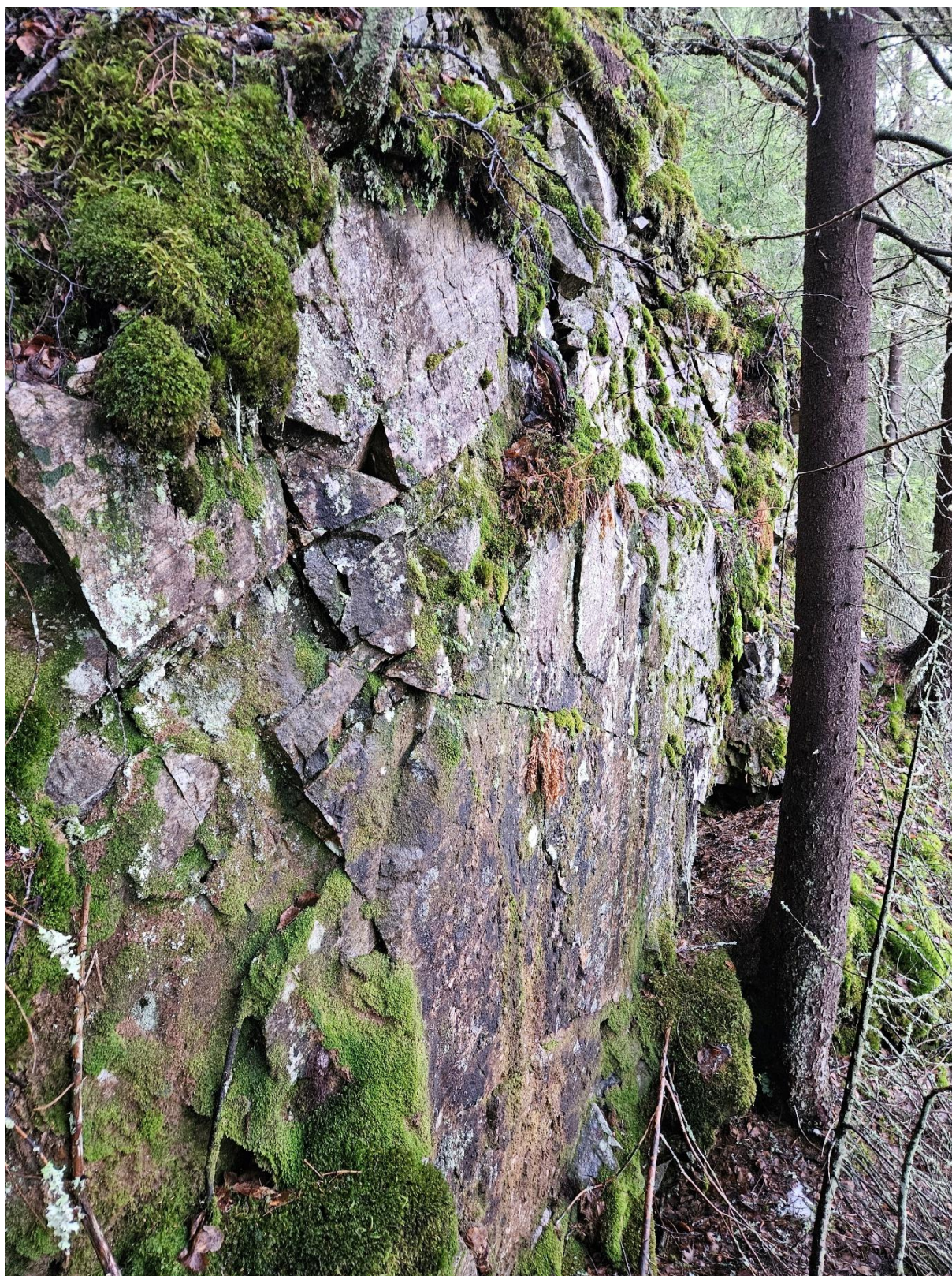
Figur 10: Deler av skrent som ligger tetteest på eksisterende drift, GPS punkt 7.
