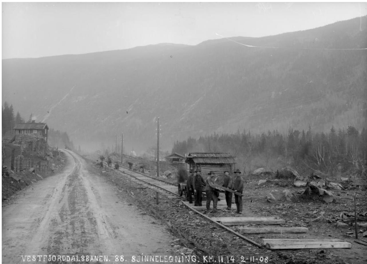
Figur 4-13: Rjukanbanen under bygging, i bakgrunnen skimtes Dal kirke. Foto: Norsk Industriarbeidermuseum.
