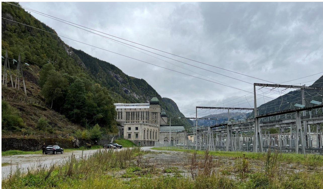
Figur 1-4. Såheim utendørsanlegg til høyre i bildet og Såheim kraftverk i bakgrunnen. Det vil etableres to master på venstre side av veien i bildet. Bildet er tatt i retning vest.
