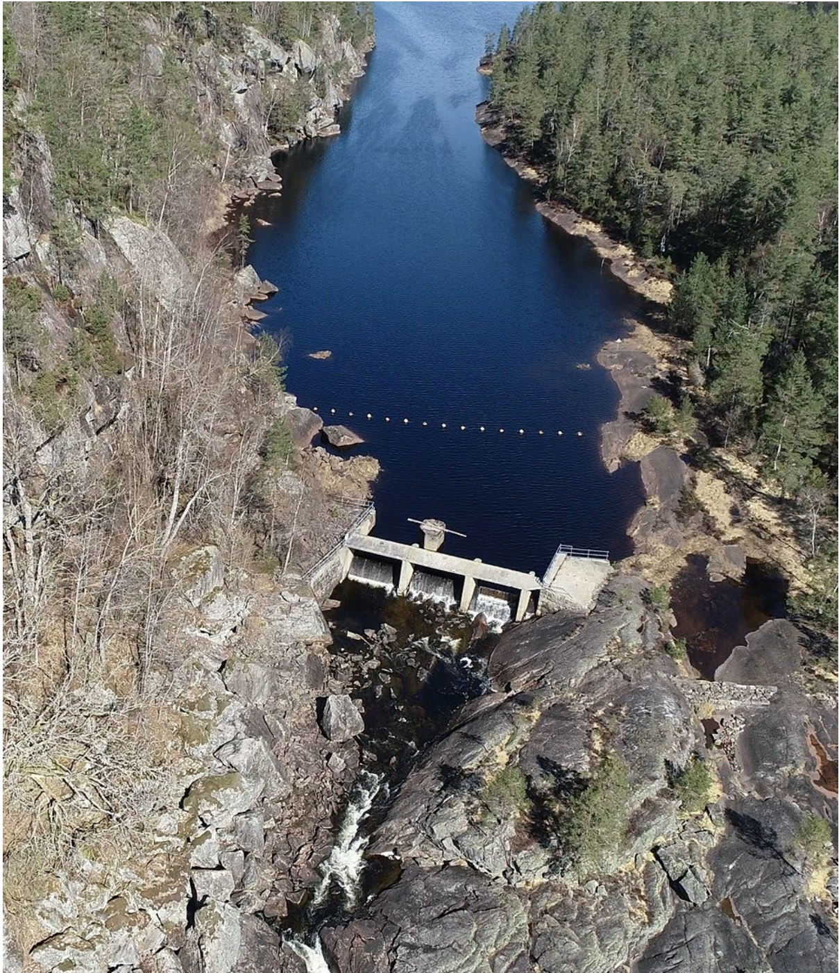
Dronebilde nedstøms terskel ved utløpet av Kolstraumfjorden. Vannstanden ca 10 cm over terskelhøyde som er på kote 159,28.
