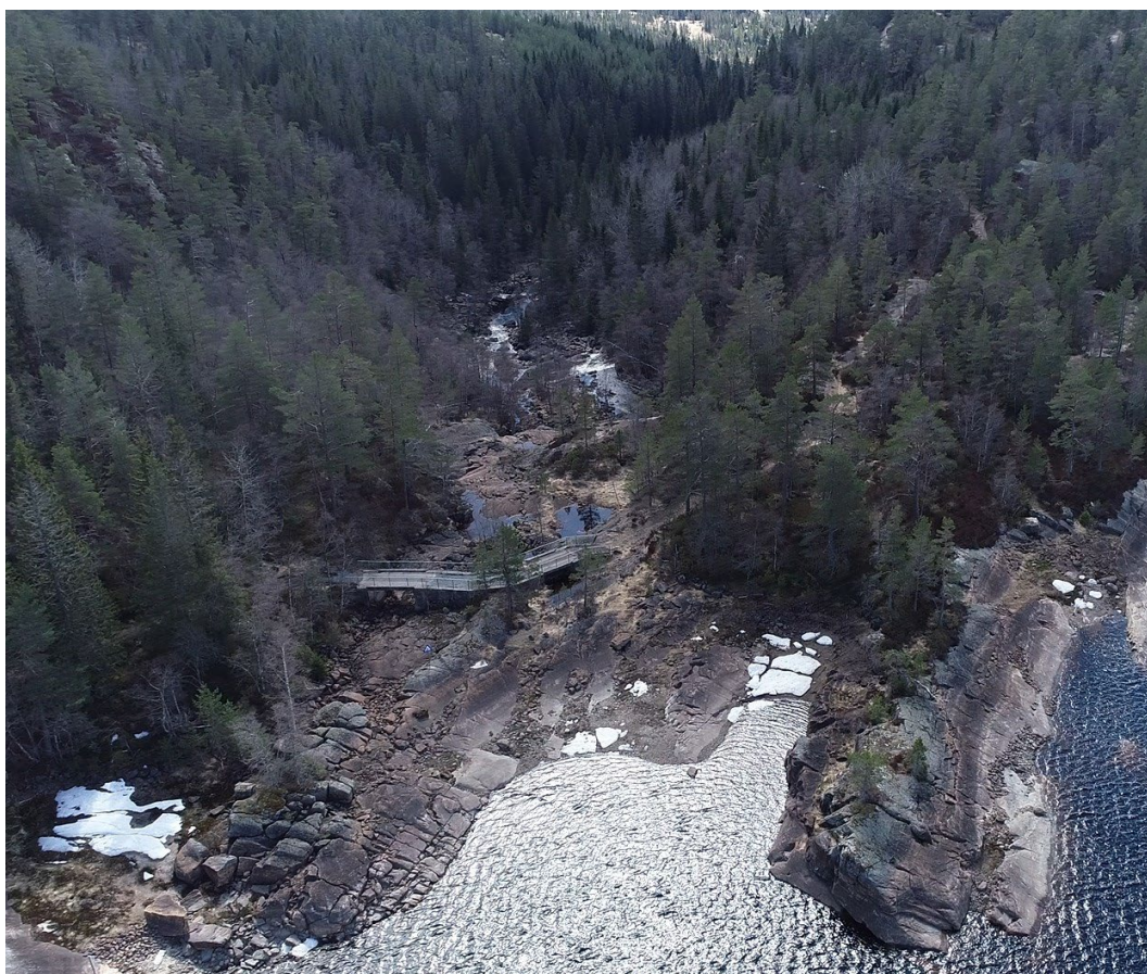
Dronebilde utløpet av Vikstølvatnet til Håtveitåna
