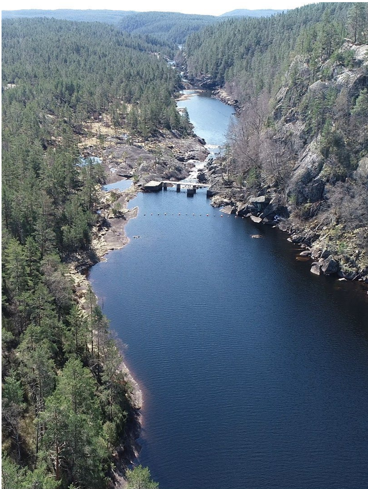
Dronebilde oppstrøms terskel ved utløpet av Kolstråumfjorden Kolstråumfjord
