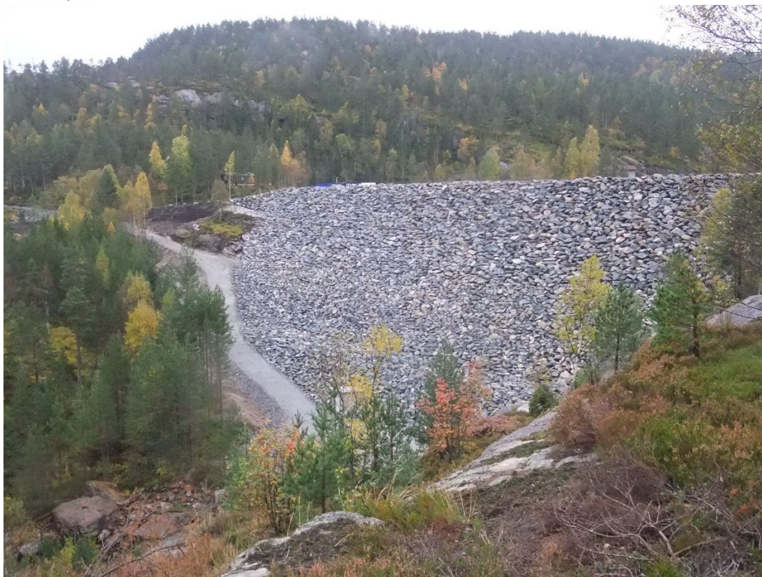
Nedstrøms dam Eptevatn (okt 2015)
