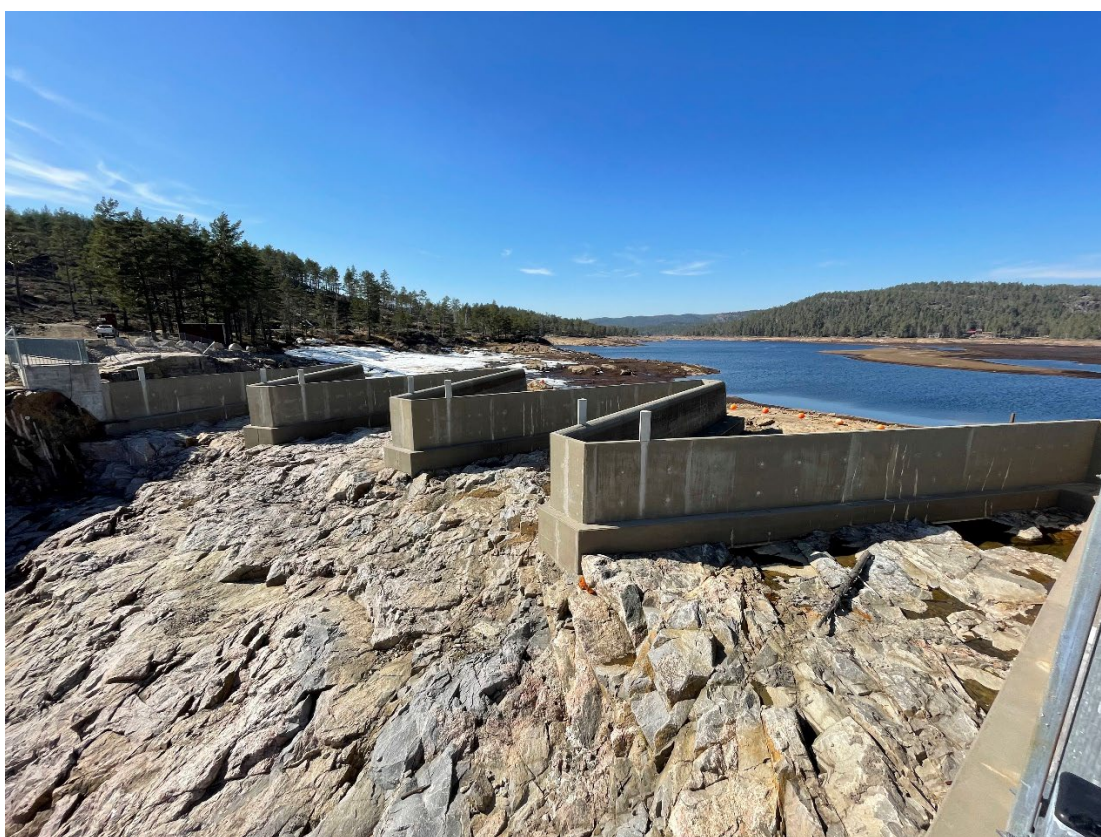
Flomoverløp – nedstrøms dam (18-04-2022)
