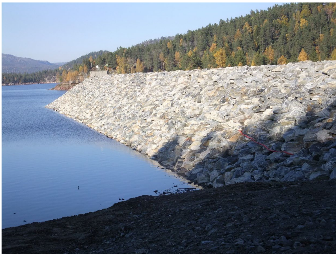
Oppstrøms dam Eptevatn (okt 2015)
