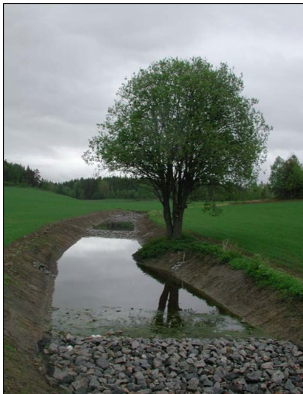
Figur 23. Bekkeåpning med energidrepende tiltak (fangdam)
