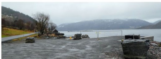
Bilde 3 Bildene viser en typisk kai for Elektron (Isane, Bremanger)
