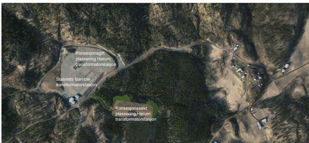
Figur 3-4. Figuren viser opprinnelig (konsesjonsgitt) og nå konsesjonssøkt lokalisering av Herum transformatorstasjon.
