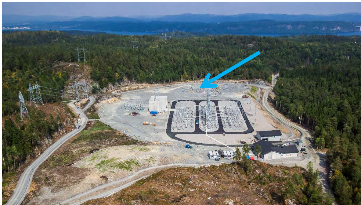
Figur 2-1. Blå pil viser det areal der Lede i 2018 fått konsesjon til å bygge Herum transformatorstasjon. Bildet viser Statnetts Bamble transformatorstasjon under bygging. Bildet er tatt retning øst med Frierfjorden i bakgrunnen.
