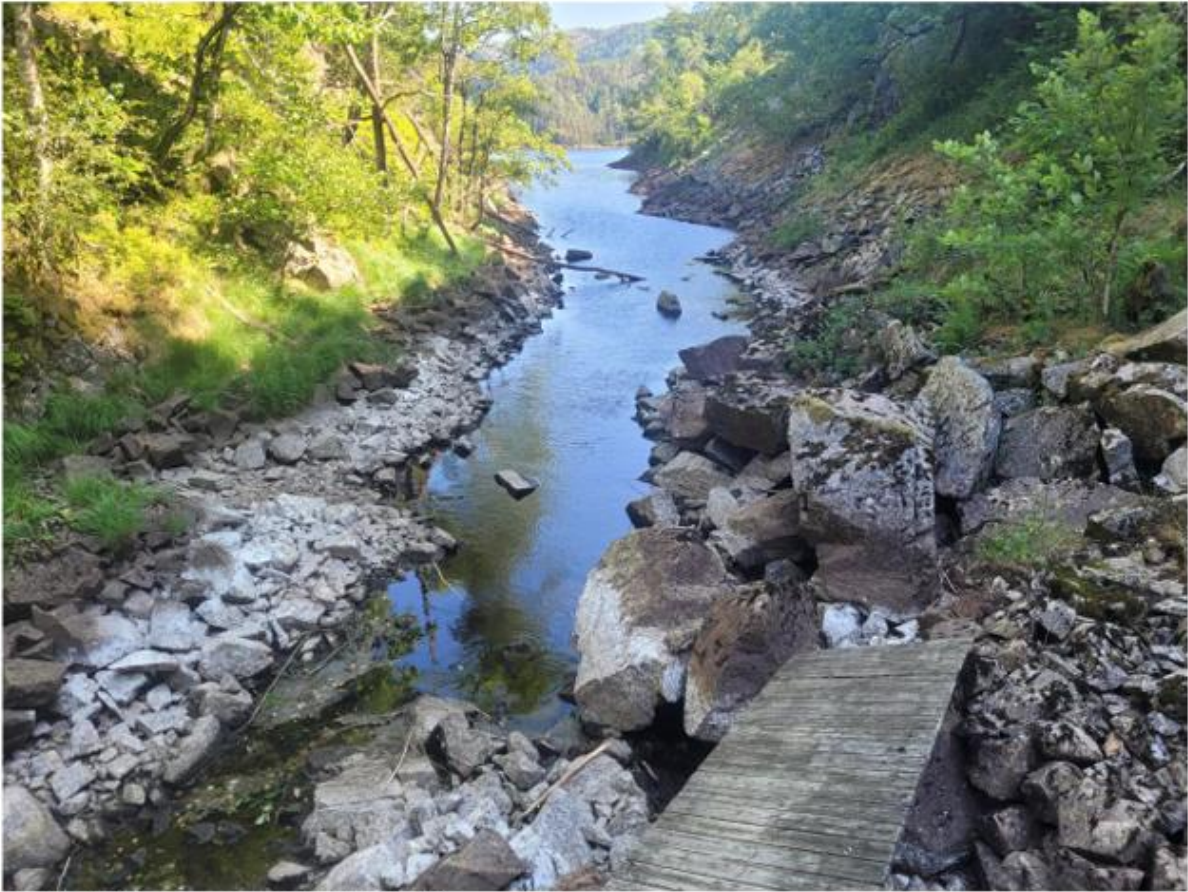
Figur 6. Utsikt oppstrøms fra utløpet. VST 6,373m
