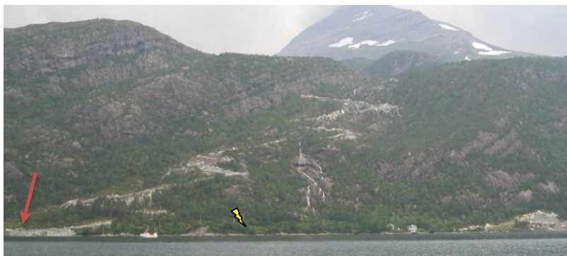
Bilete 2: Oversiktsbiletet viser til høgre husa i Lunden og til venstre planlagt plassering påhogg adkomsttunnel kraftstasjon (raud pil). Lunden tr.stasjon bygt, etter at biletet vart teke, markert med gult lyn.
