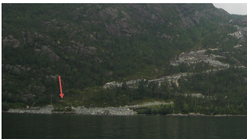
Bilete 3: Planlagt plassering påhogg adkomsttunnel kraftstasjon markert med raud pil. Lunden tr.stasjon utanfor høgre biletkant. Avløpstunnel er planlagt like til venstre for påhogg adkomsttunnel (avløp direkte til Nordfjorden).
