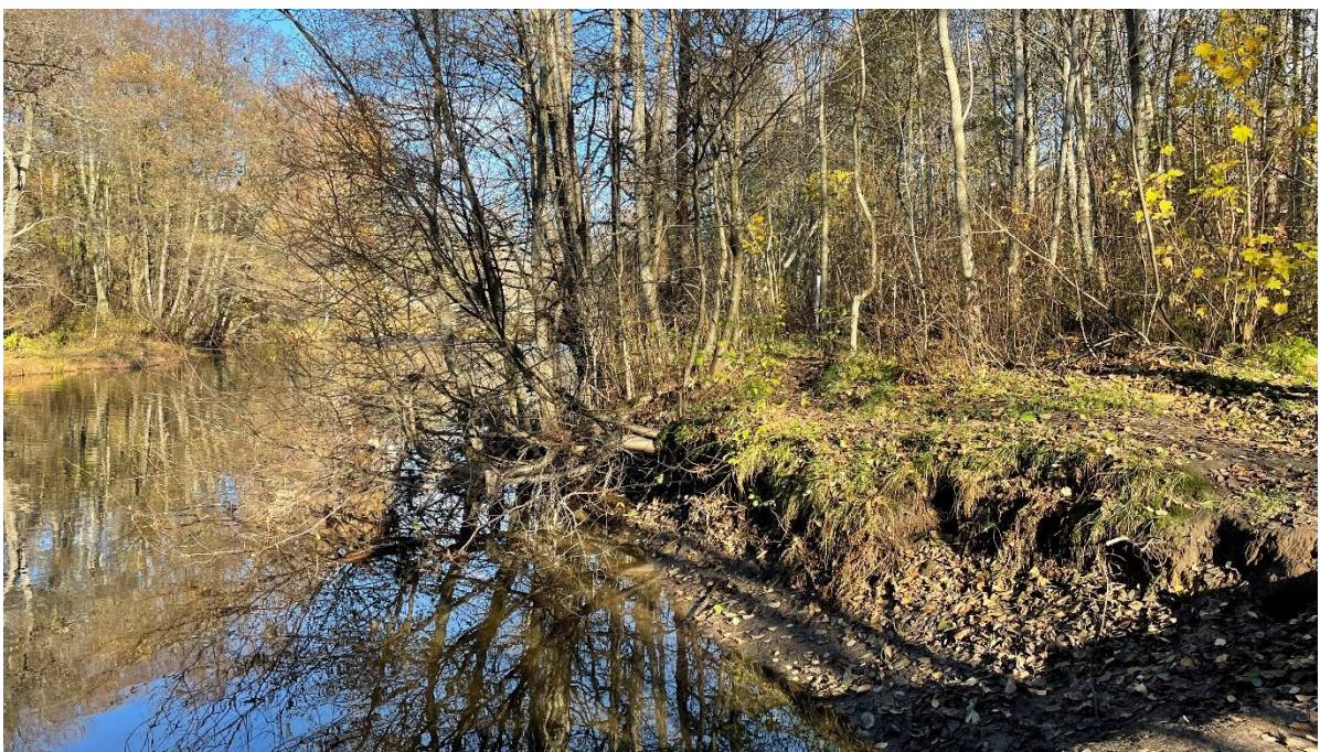
Bilde 5-4: Erosjon observert ved Akerselva sør for Kjelsåsveien 160-162.
