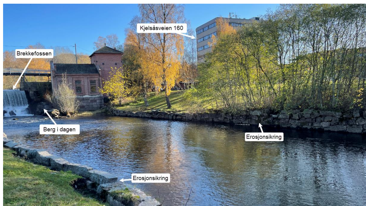
Bilde 5-1: Bilde som viser berg i dagen og erosjonssikring ved Akerselva. Bildet er tatt i retning øst/sørøst.
