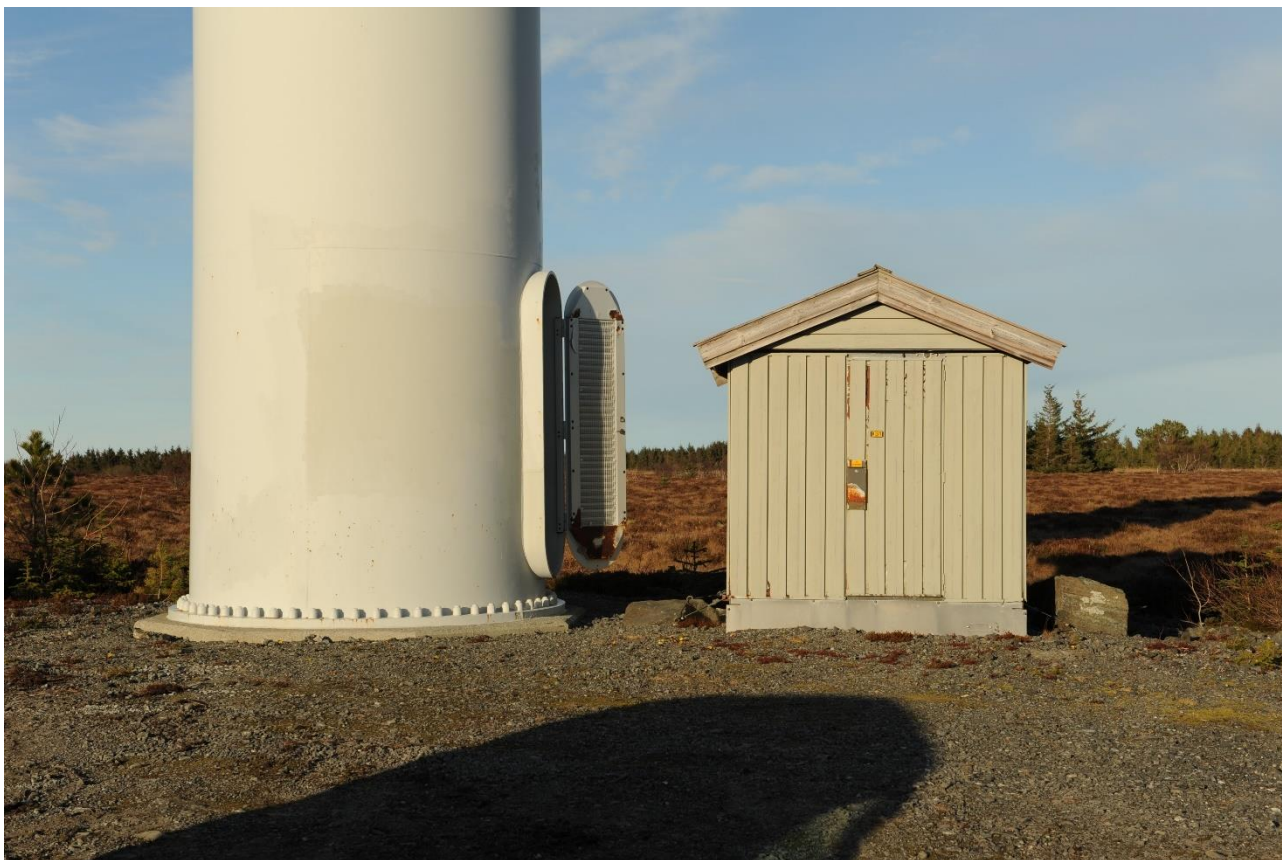
Figur 7: Både tårn og koblingsskapet skal gjenbrukes og situasjonen på bakken ved hver turbin forblir derfor uendret.
