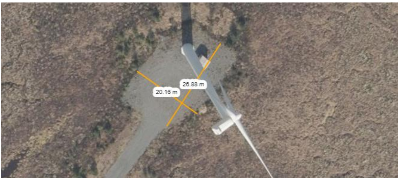
Figur 8. Ved hvert turbinpunkt er det et gruset areal på ca. 20 x 30 meter. Grusarealet forblir uendret i størrelse, men vil bli forsterket med ny grus innen demontering/montering.
