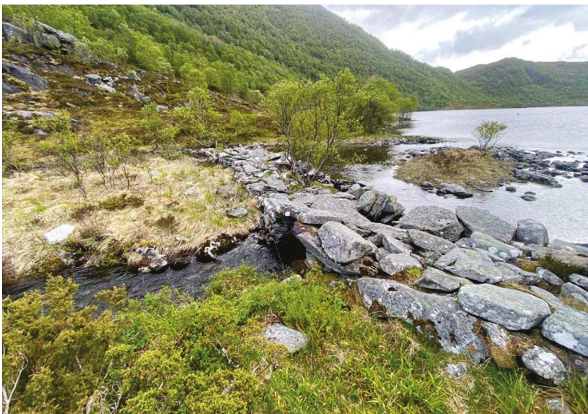
Figur 9 Steinmur og steinbru ved utløpet til Berstadelva (Foto: Rådgivende Biologer AS).
