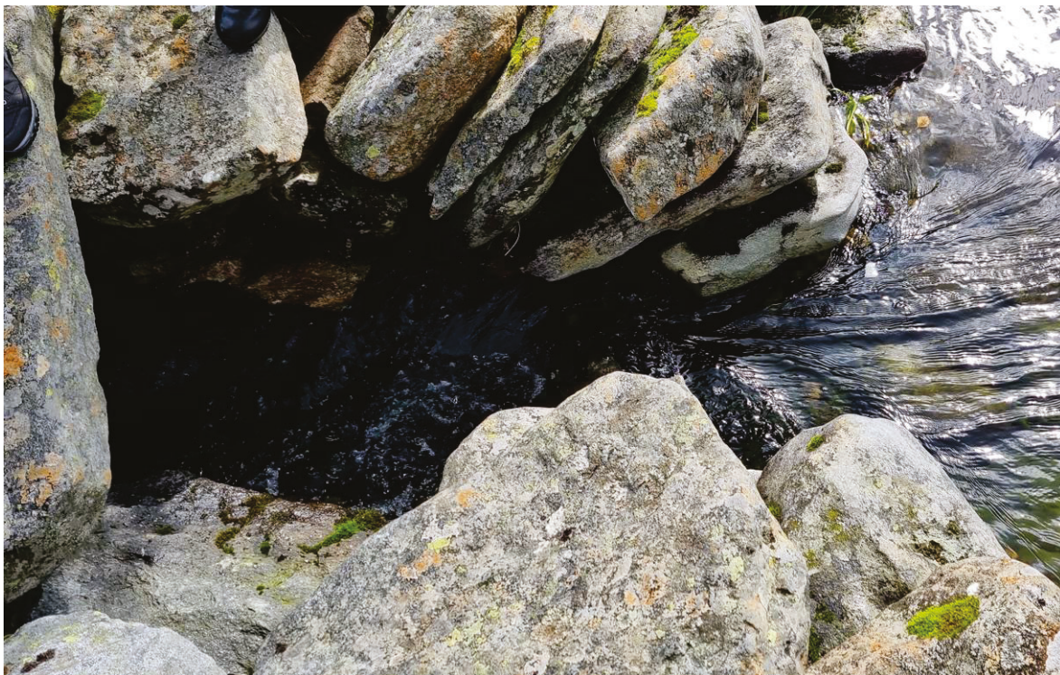
Figur 10 Ved steinbrua, opning i steinmuren der treluka var monterert (Foto: Nordplan).
