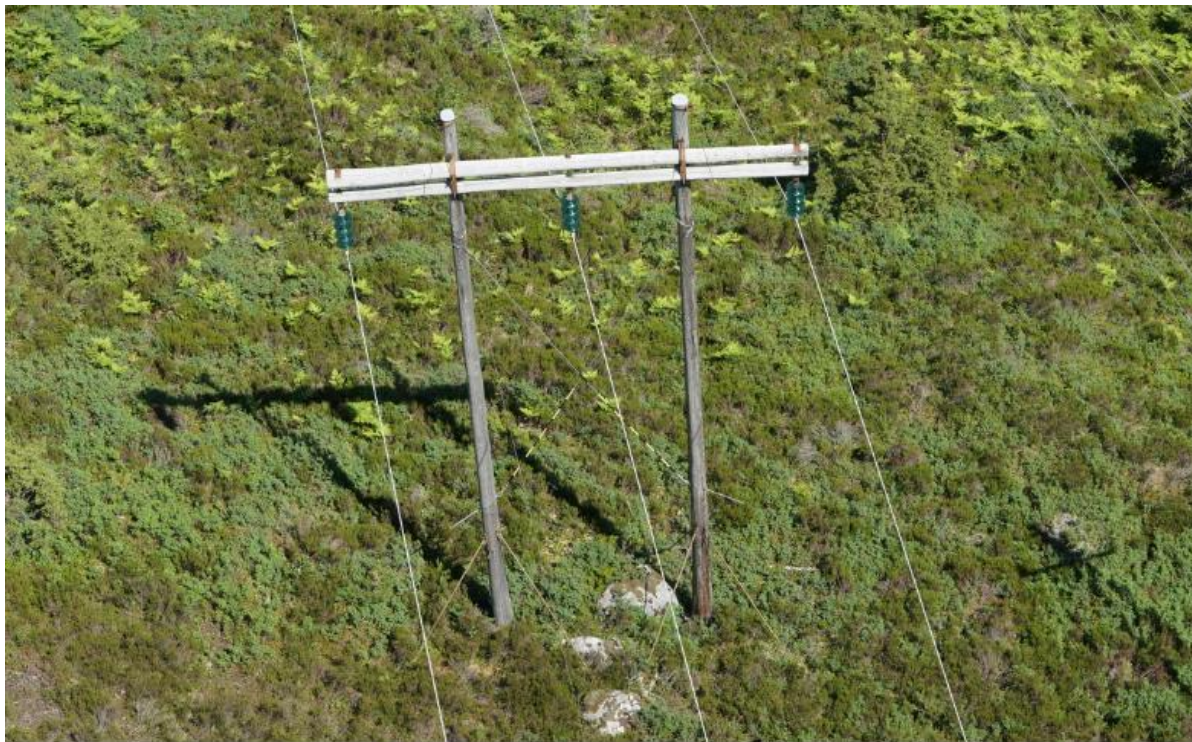
Figur 3 - Dronebilde av mast på strekningen mellom Finså og Oftedal som skal rives.
