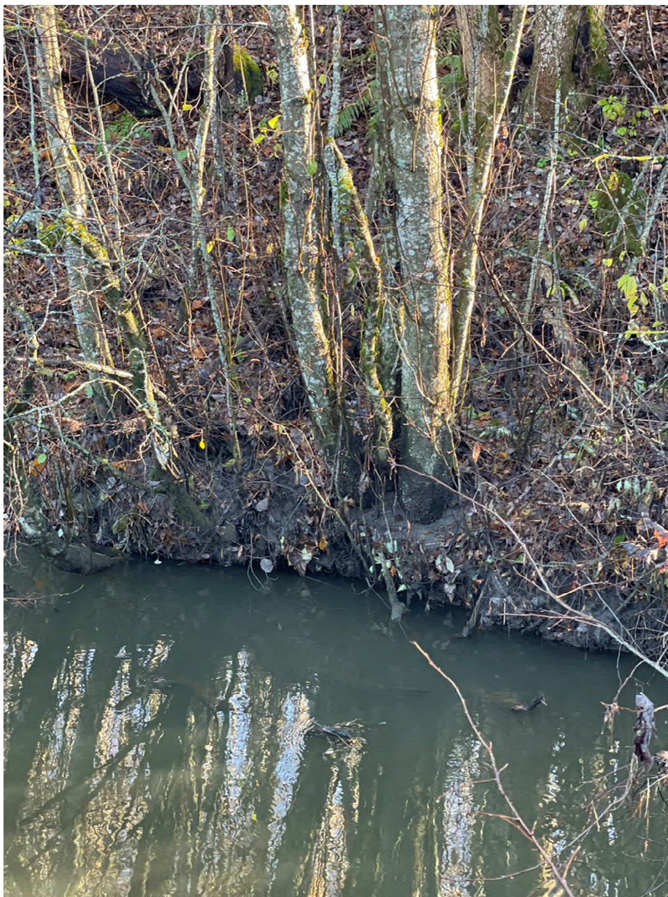
Figur 1-10. Aktiv erosjon ved en bratt skråningskant på østsiden av elven. Farget vann og større enkelte trær som har veltet ut i elven som indikerer aktiv erosjon (men trær står hovedsakelig vertikalt). Klassifiseres med "lite erosjon" da det ikke observeres noen tidligere overflateutglidninger. Se punkt 9 i kartet for plassering.
