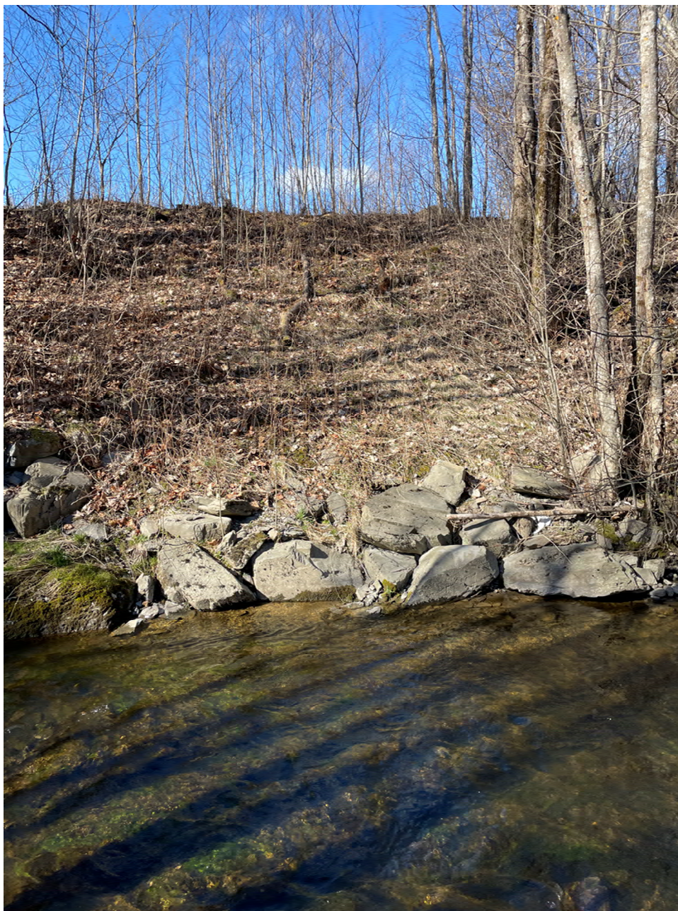
Figur 1-3. Naturlig erosjonsbeskyttelse på vestsiden av elveløpet. Det er også mulig at denne delen av Øverlandselva har blitt erosjonssikret tidligere. Det er observert mulig berg i dagen sør for punktet på vestsiden av elven. Området kategoriseres derfor med «ingen erosjon». Se punkt 2 i kartet for ca. plassering.
