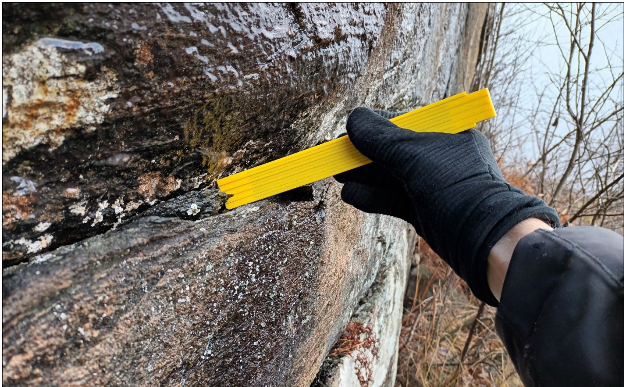
Figur 7: Det er observert nokre horisontale sprekkeplan langs foliasjonsplana. Foliasjonsplana har slakt fall inn i hammaren, og fjellet har støtte i seg sjølv. Hammaren er elles vurdert som massiv. Infopunkt 1.
