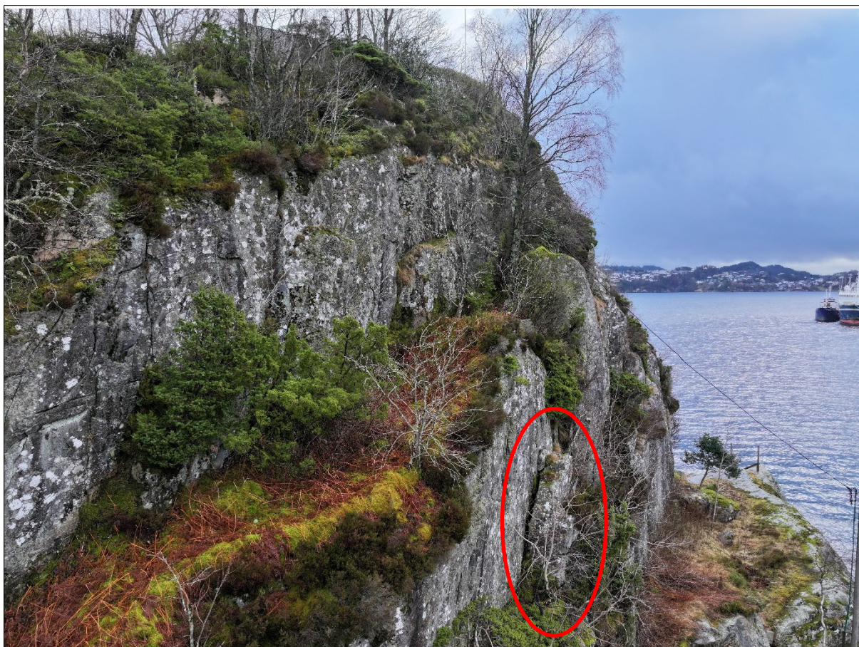
Figur 9: Øvre del av hammarpartiet er vurdert som massivt og stabilt, utan vesentleg sprekkdanning. Det ligg ei nær avløyst blokk i andre hylleparti av hammaren (markert med raudt omriss). Blokka har sprekkdanning i underkant og i bakkant, men partiet er ikkje påverka av sprengingsarbeidet i samband med utbygginga av kaiområdet, og det er vurdert at blokka har feste i bakkant og har låge der lenge. Infopunkt 3.
