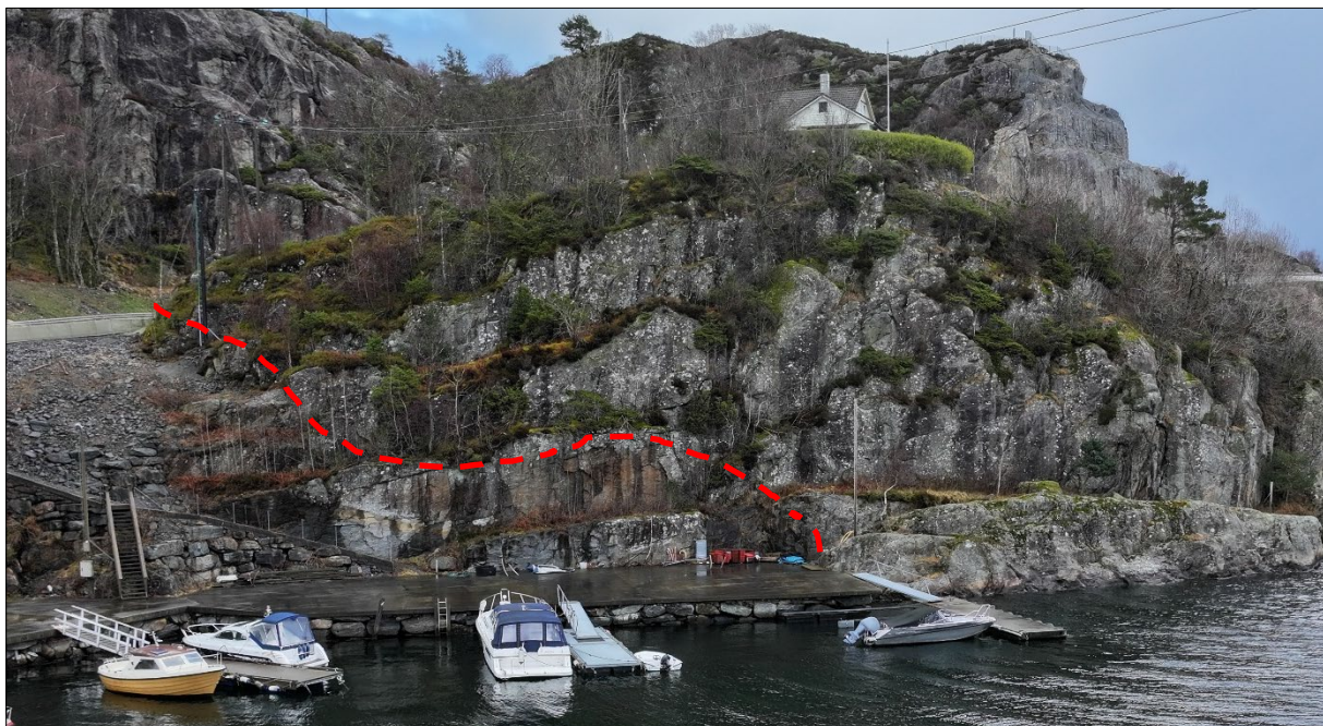
Figur 6: Hammaren er delt opp i 4 hammarparti med høyder mellom 3 – 6 meter, med små hyller mellom partia. Nedre og nordaustleg del av hammaren er utsprenge skjeringar i samband med utbygging av kaia, medan dei to øvre hammarpartia er naturleg fjell (omtrentleg markert med raud, stipla linje).
