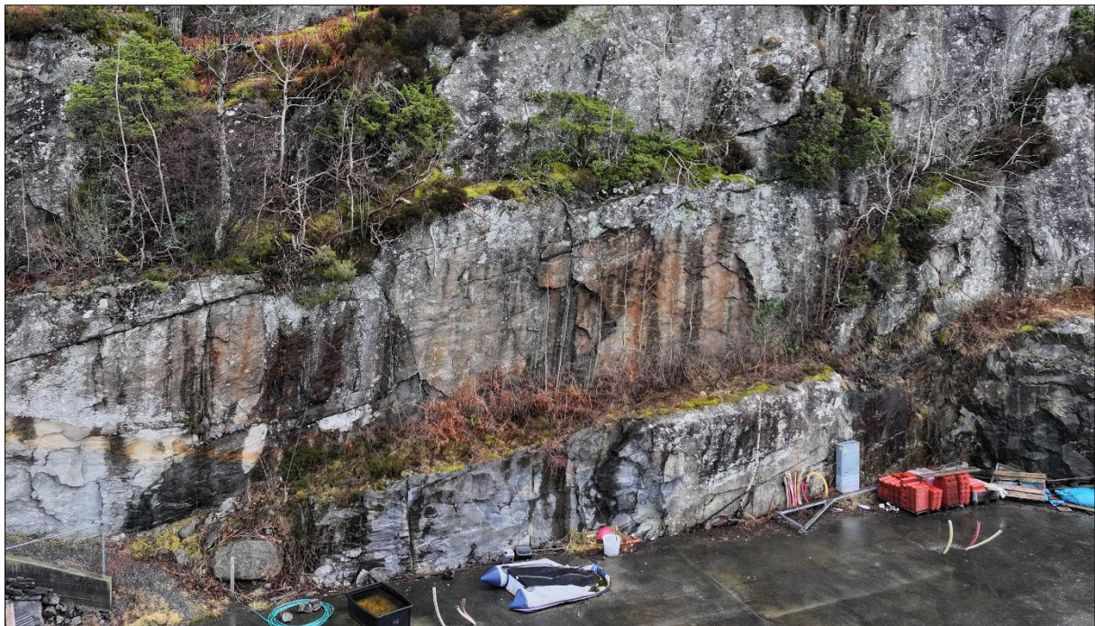
Figur 19: Nedre del av hammarpartiet ovanfor kaia. Det er nokre tynne flakdanningar langs dei loddrette hammarpartia, men det er ikkje observert gjennomgåande sprekker i desse og fjellet er hovudsakleg vurdert som massivt.
