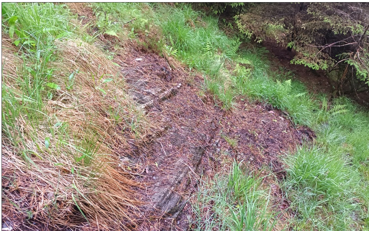
Figur 6: Fjellblotting i skråninga i sørleg del av kartleggingsområdet. Bergarten er vurdert som massiv og utan vesentleg sprekkdanning, og består av granittisk gneis, og det er observert foliasjonsplan med fall mot nordvest. Det vart observert forvitring langs foliasjonplana, men ingen sprekkdanning. Infopunkt 6.
