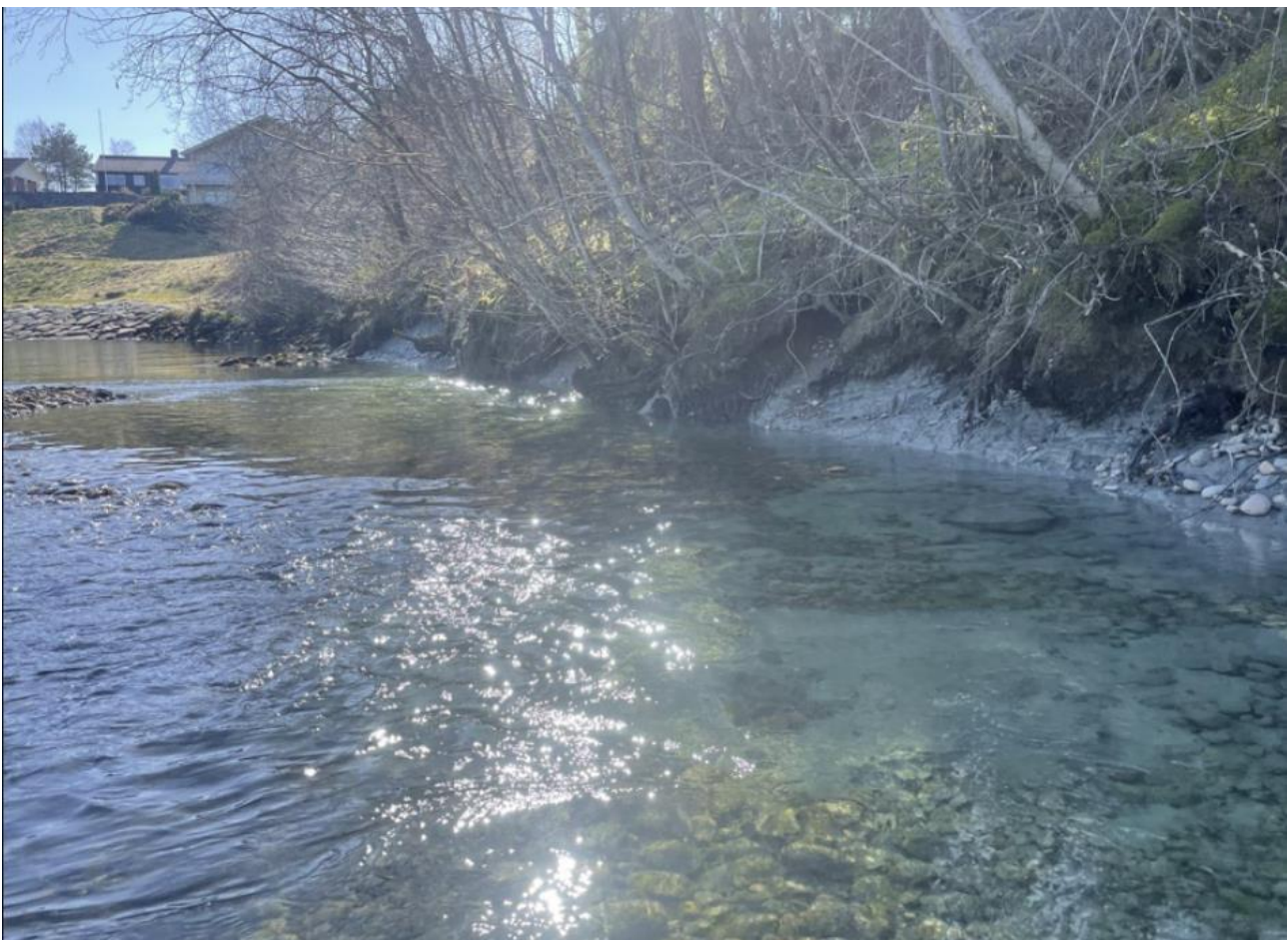
Figur 4-2: Bilde som viser erosjon langs elvebredden i nærheten til boreposisjon 2410-5. Bildet er tatt mot sør.
