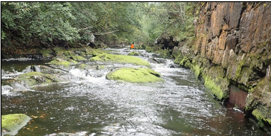
Inntaksområdet. Inntaksluke sees i mur til høyre i bildet.
