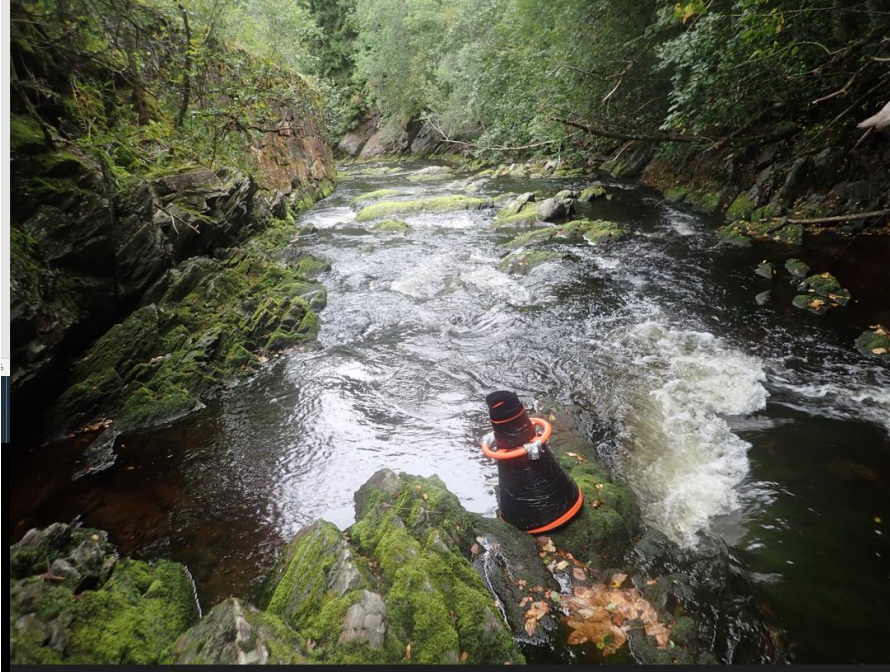
Øvre del av berørt elvestrekning. Inntaksterskel vil bli i bakkant i bildet
