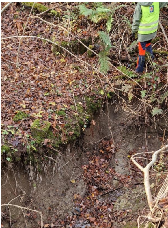
Bilde 3, Typisk bilde fra området med kraftig erosjon
