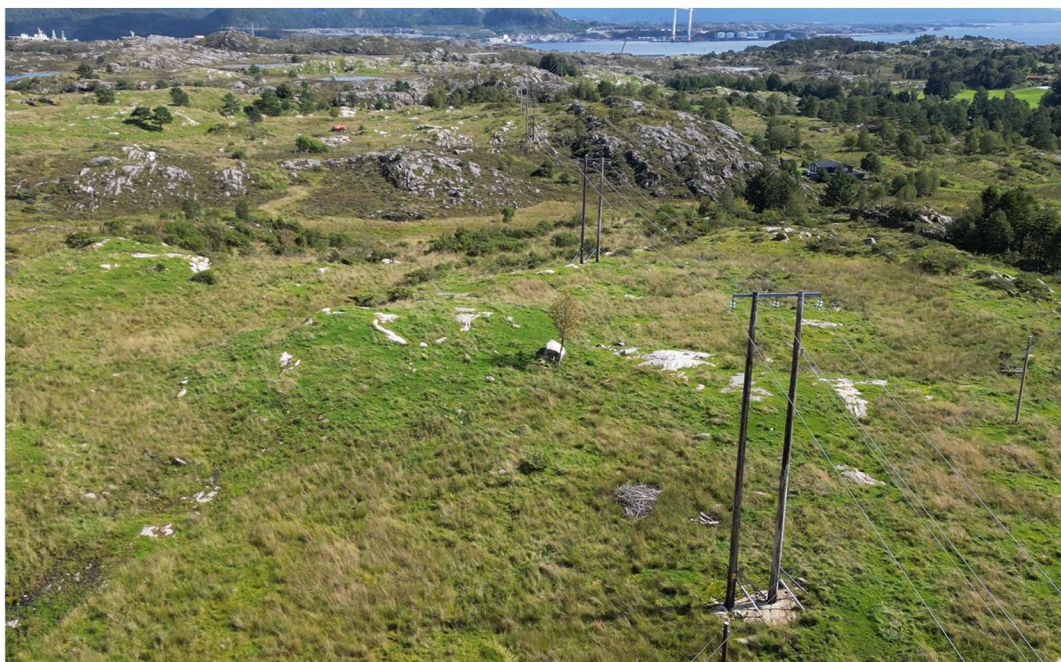
Figur 11. Trasé for ny 132 kV kraftledning hvor denne vil gå parallelt med eksisterende 22 kV ledning. Vi ser østover mot Raunholmen og Skipavika. Foto: BKK.
