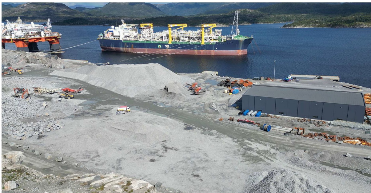
Figur 7. Skipavika næringspark sett fra vest. Raunholmen transformatorstasjon plasseres nede i forgrunnen i bildet. Foto: BKK.
