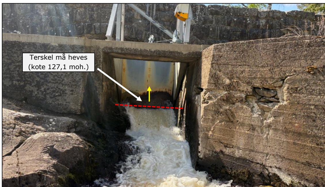
Figur 9-8 - Luke ved terskel
