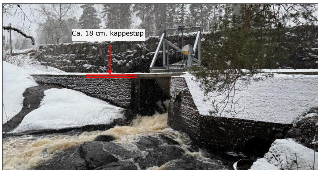
Figur 9-3 - Terskelsituasjon etter reparasjon og ombygning av ny kappestøp med glideluke (2021) - Eksisterende situasjon (bilde tatt i 2025)
