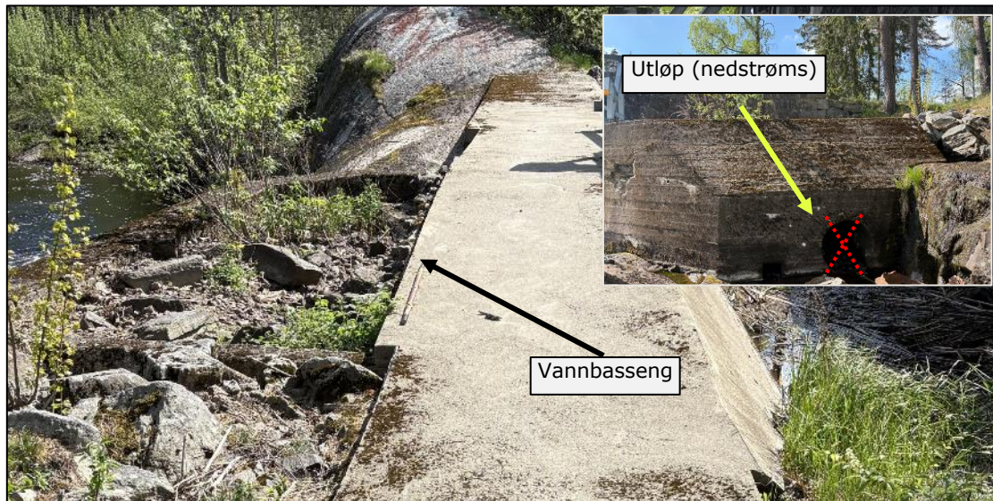
Figur 9-7 - Terskel og vannbasseng, etter-tiltakssituasjon. Vannbassenget er fylt igjen med sprengstein.
