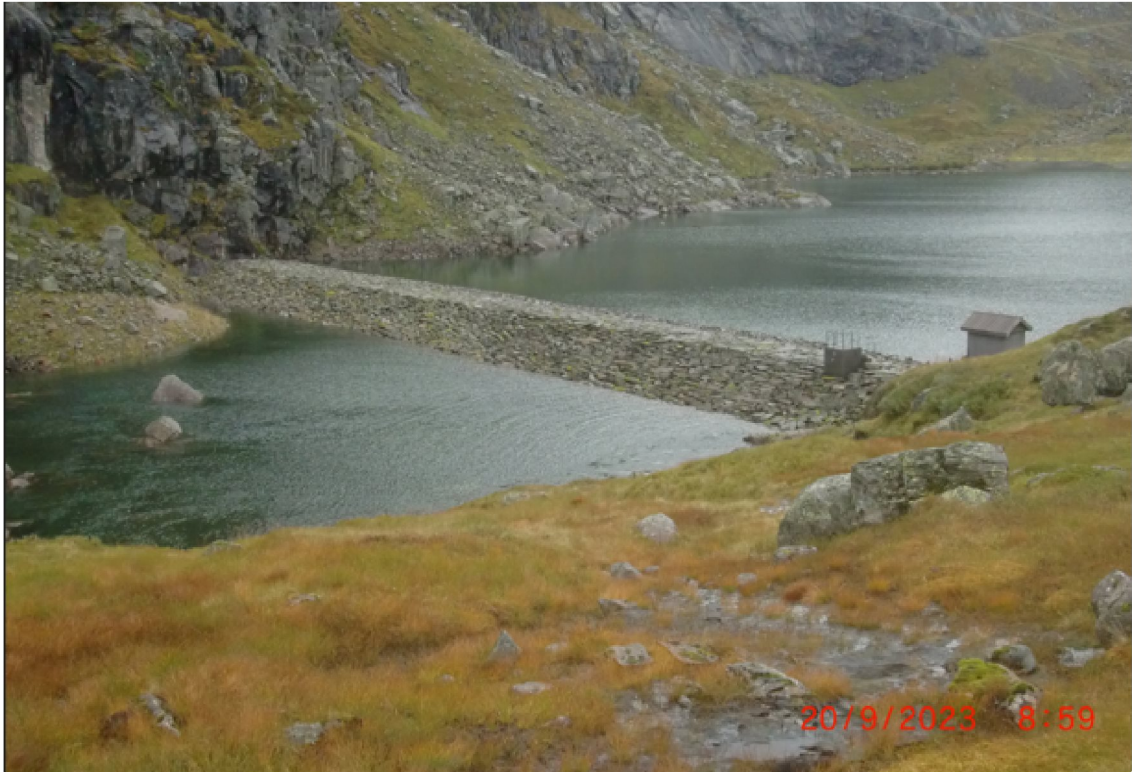
Figur 1. Dam Markjelkevatt med tappeløp til høyre på dammen. Bilde: Statkraft.
