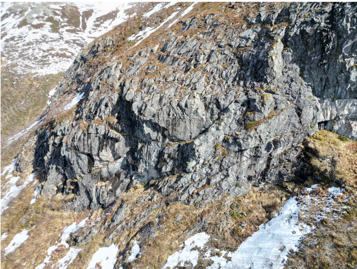
Bilde 4: Nærbilde av berskrent i den sørlige delen av påvirkningsområdet, som er registrert som løснеområde for steinsprang.
