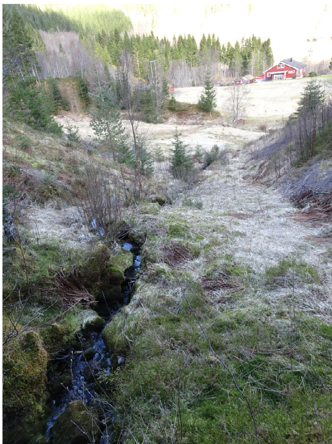
Bilde 8: Bekkeløp i definert ravine sør i området. Bekken sildrer i grove masser. Eventuelle snøskred fra løsneodene i sørlig del av påvirkningsområdet vil kanaliseres langs ravinene.
