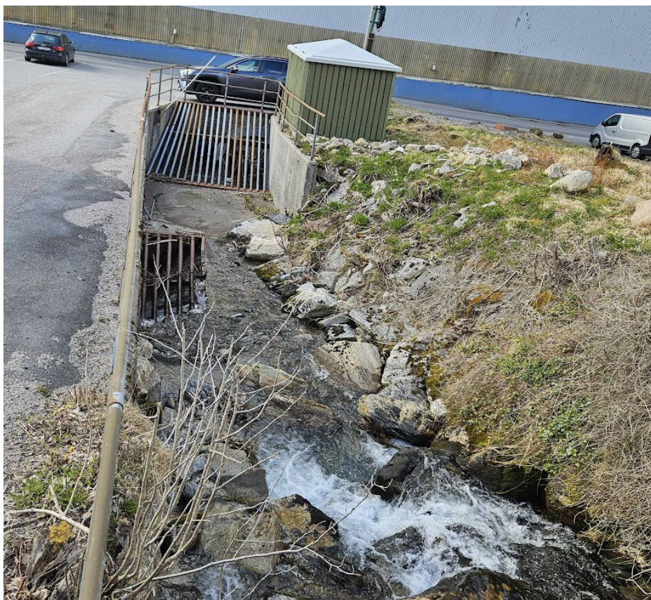
Bilde 10: Hovedkulvert og overvannskulvert som leder Langsteinselva under skipsverftet på Langstein.
