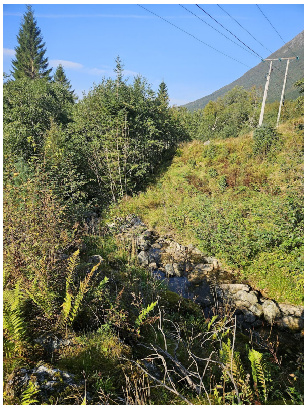
Bilde 9: Ledevoll på vestsiden av bekkeløpet Forsåna langs en bratt sving ved ca. kote 60. Ledevollen er ca. 4 m høy og vurderes å ha god effekt i å hindre eventuelle flomskredoverløp mot bebyggelsen i Fjordvegen.
