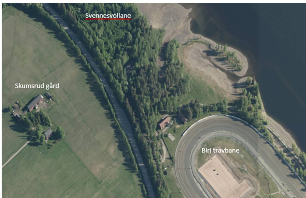
Figur 6-2: Skråfoto for området ved Mjøsa som planlegges for råvannspumpestasjon og landtak for ledninger. Kilde: Gjøvik kommune
