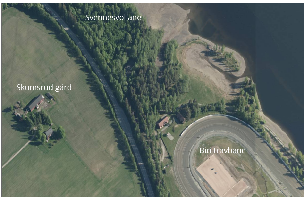
Figur 6-1 Skråfoto for området ved Mjøsa som planlegges for råvannspumpestasjon og landtak for ledninger.
