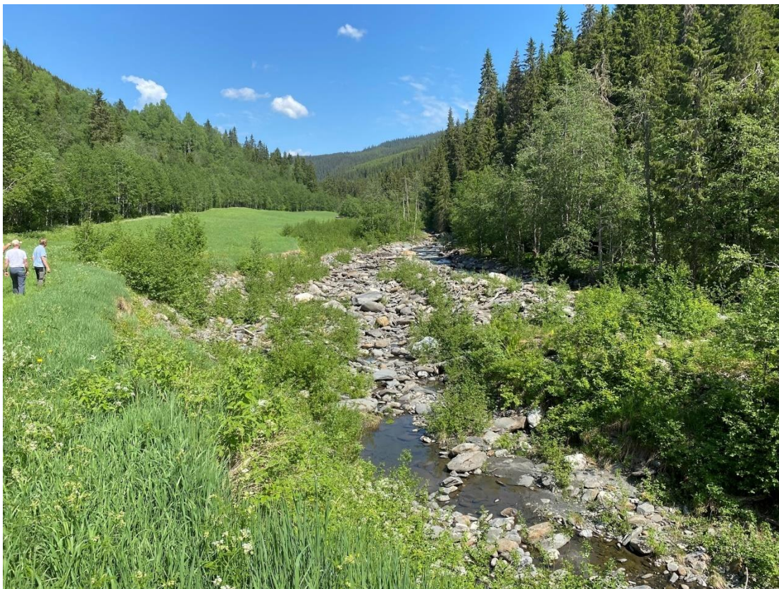
Figur 2. Dørja langsmed flomskadet mark.
