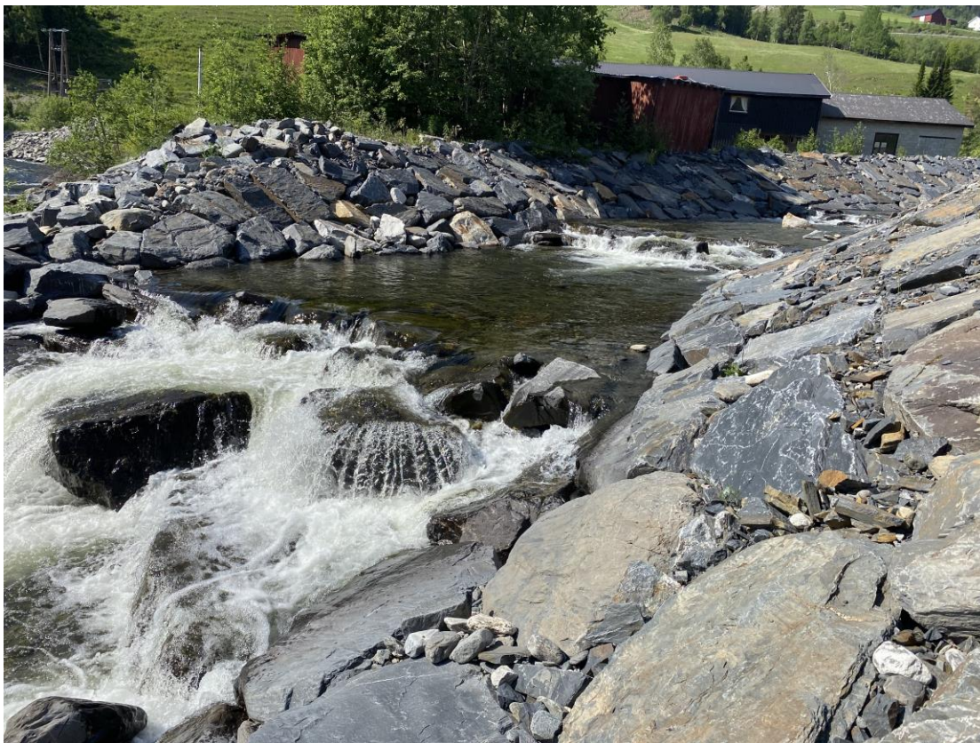
Figur 8. Dørja ved samløpet med Jøra. Bunnterskler og sideplastring er synlig.
