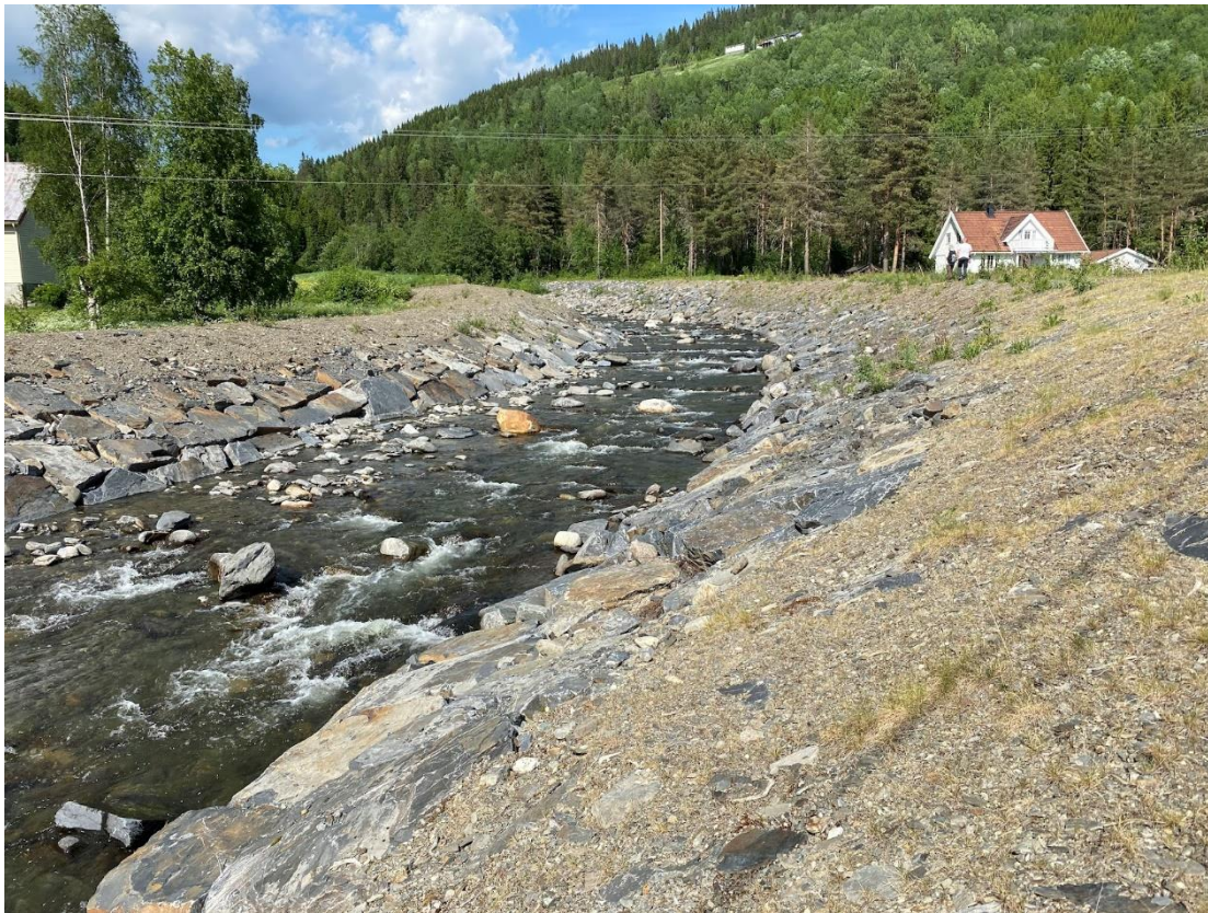
Figur 7. Dørja oppstrøms Vestringsvegen bro. Sideplastring og flomvoll er synlig.
