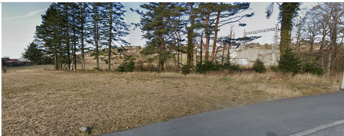
Figur 5: Det er i enden av dette jorden, og i forkant av trærne som omkranser Møllebukta dam, at Statnett søker om å etablere en ny 75 m lang adkomstvei fra Regimentveien. Muffeanlegget sees i bakgrunnen fra sør-øst. Kilde: Stavanger, Rogaland - Google Maps
