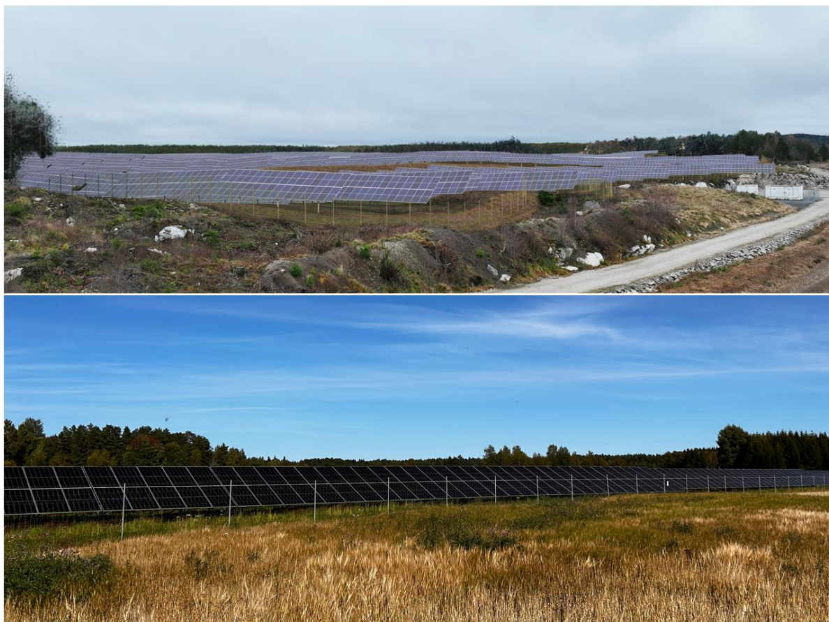
Figur 10 - Inngjerding av solkraftverk
