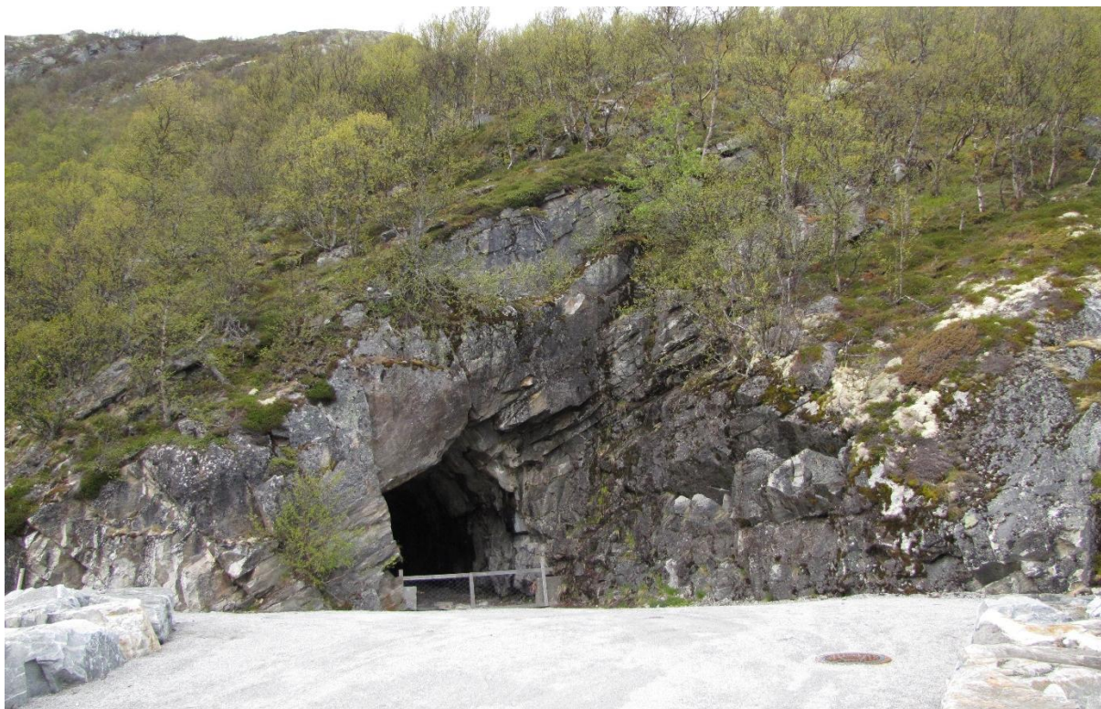
Bilde 16. Tunnelinnslag i vestenden av demningen, som vil utvides noe. Trekk av villrein som krysser damkrona skjer oftest i tråkk til venstre for det eksisterende innslaget (like til venstre for bildet).
