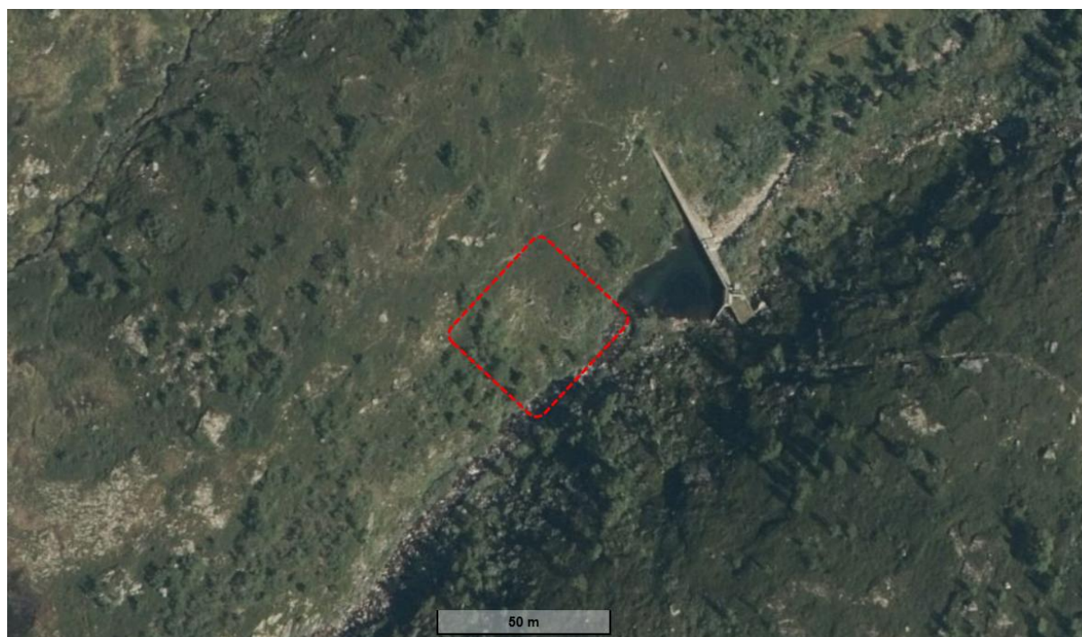
Bilde 20. Flyfoto av planområdet for Svingesjakt ved bekken Tvinna. Ca. areal for varige inngrep er markert med stiptet rektangel. I tillegg vil et større areal utenfor dette brukes midlertidig i anleggsfasen. Eksisterende dam og demning i Tvinna ses nedstrøms (til høyre for) planområdet.
