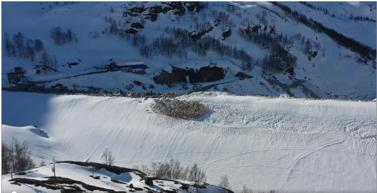
Bilde 1. Villrein som passerer østover på Viddalsdammen, 20.04.2023. Anleggsarbeidet ble midlertidig stanset før kryssingen, etter gjeldende prosedyre. Kilde: Hafslund Eco (2023).
