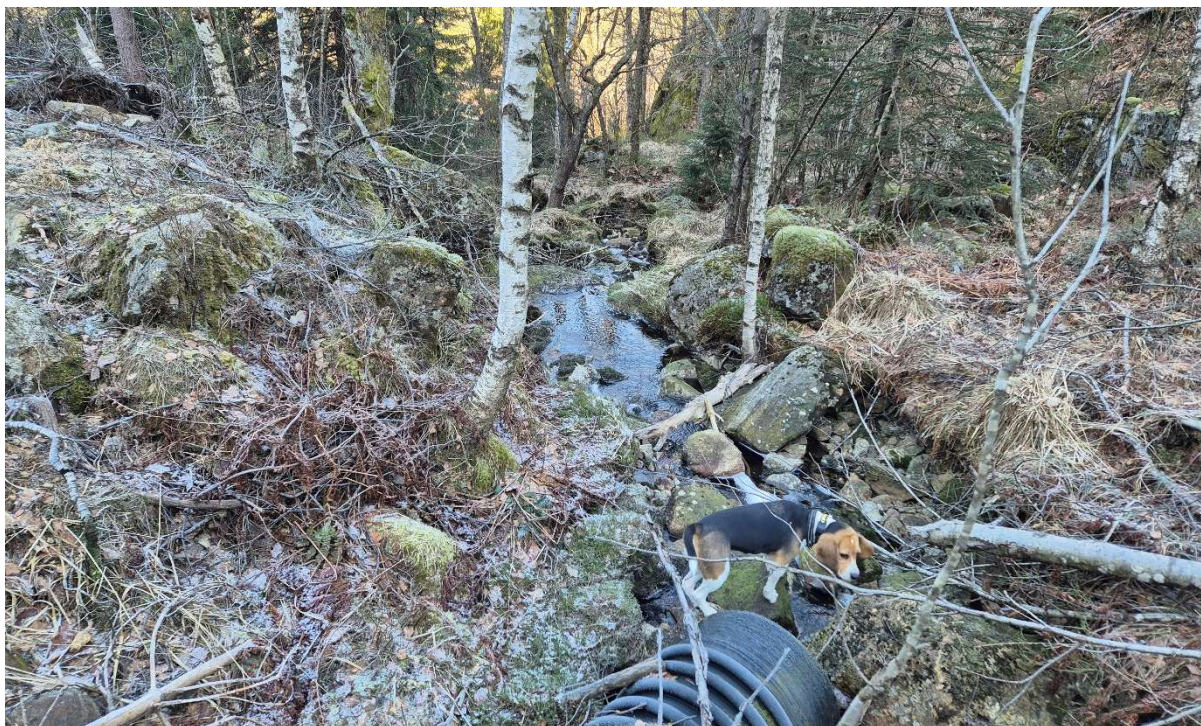
Figur 4: Bekk fra Toftelandsmyra, stikkrenne for vann fra den andre myra synlig nederst i bildekanten. Mye steiner i bekkefare.
