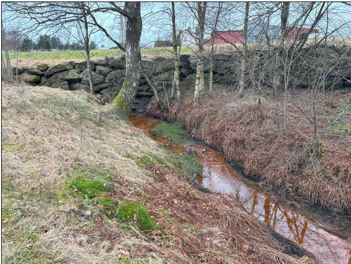
Figur 12 Ny stikkrenne under vei vil ledes til bekk som drenerer mot rensedam ved Stokkavatnet. Det vil i forbindelse med etablering av ny stikkrenne gjennomføres erosjonssikringstiltak ved utløp til bekk.
