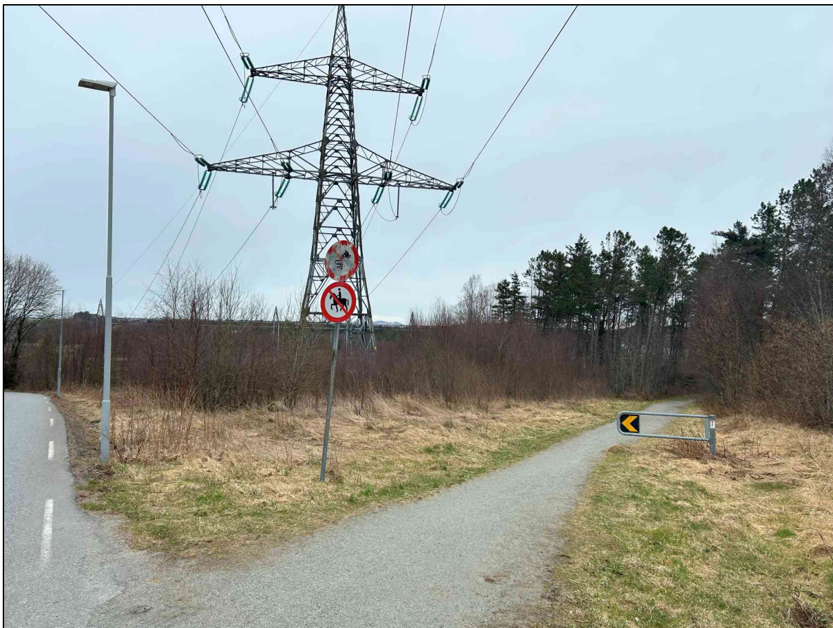
Figur 8 Et ca. 1,3 daa stort areal rundt eksisterende 300 kV mast/ledning kan benyttes til riggareal, men må hensynta overhengende nett. Bildet er tatt fra Alvasteinveien sør for eksisterende stasjon.
