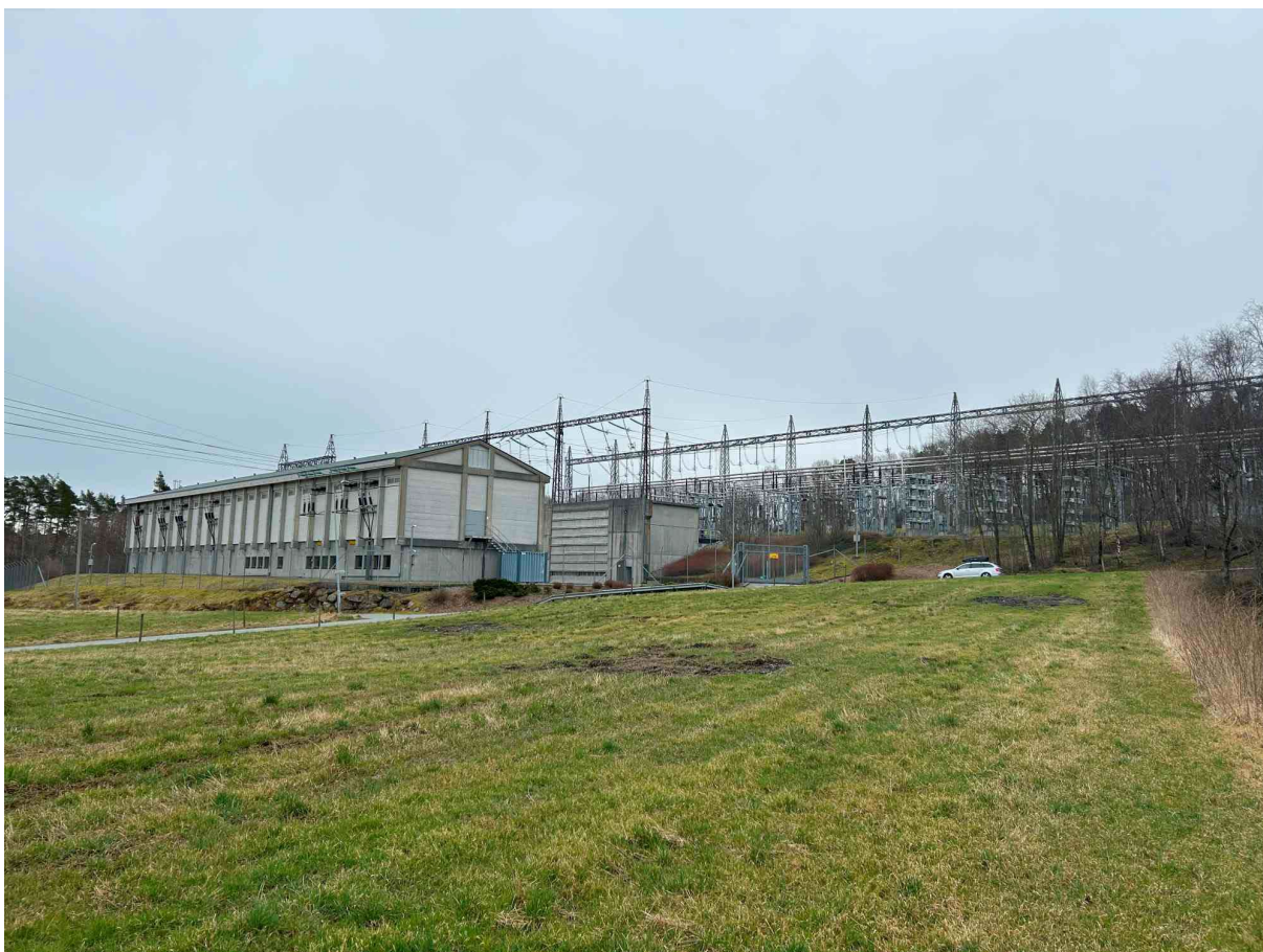
Figur 3 Eksisterende Stølaheia transformatorstasjon sett fra nord.
