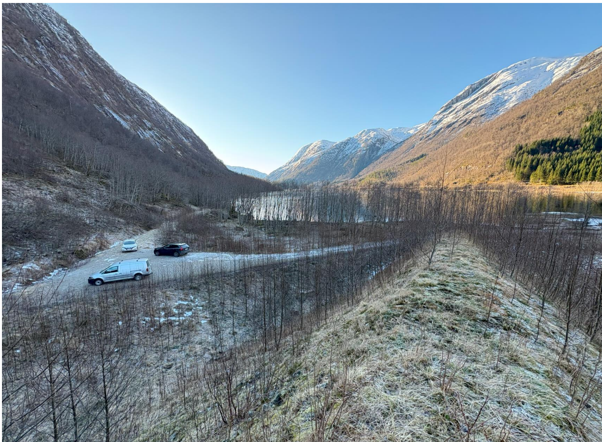
Figur 32 Steinslandsvatnet sett fra Steinsland koblingsstasjon mot Storeholmen
