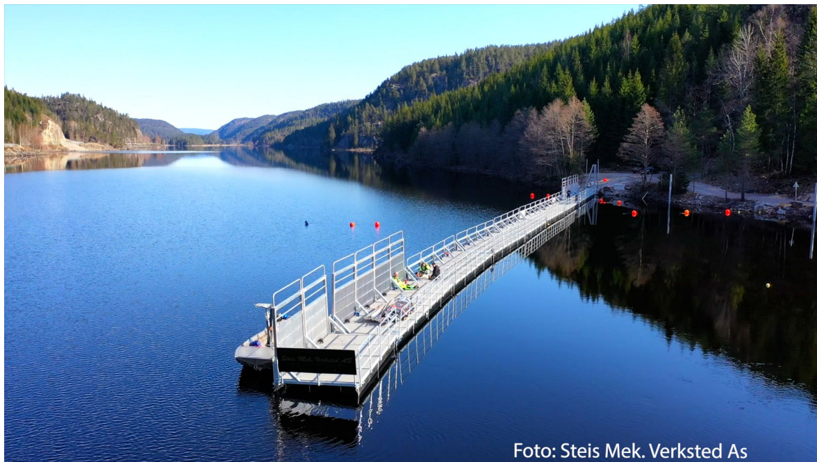
Figur 4. Ledegjerdet for smolt oppstrøms inntaket til Laudal kraftverk. De ytterst grindpanelene er hevet mens resten står i driftsposisjon.
