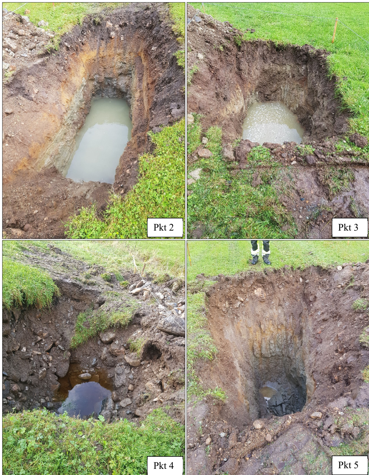
Figur 6. Foto av punkt 2, 3, 4 og 5. Grunnvann er synlig i tre av de fire gropene.
