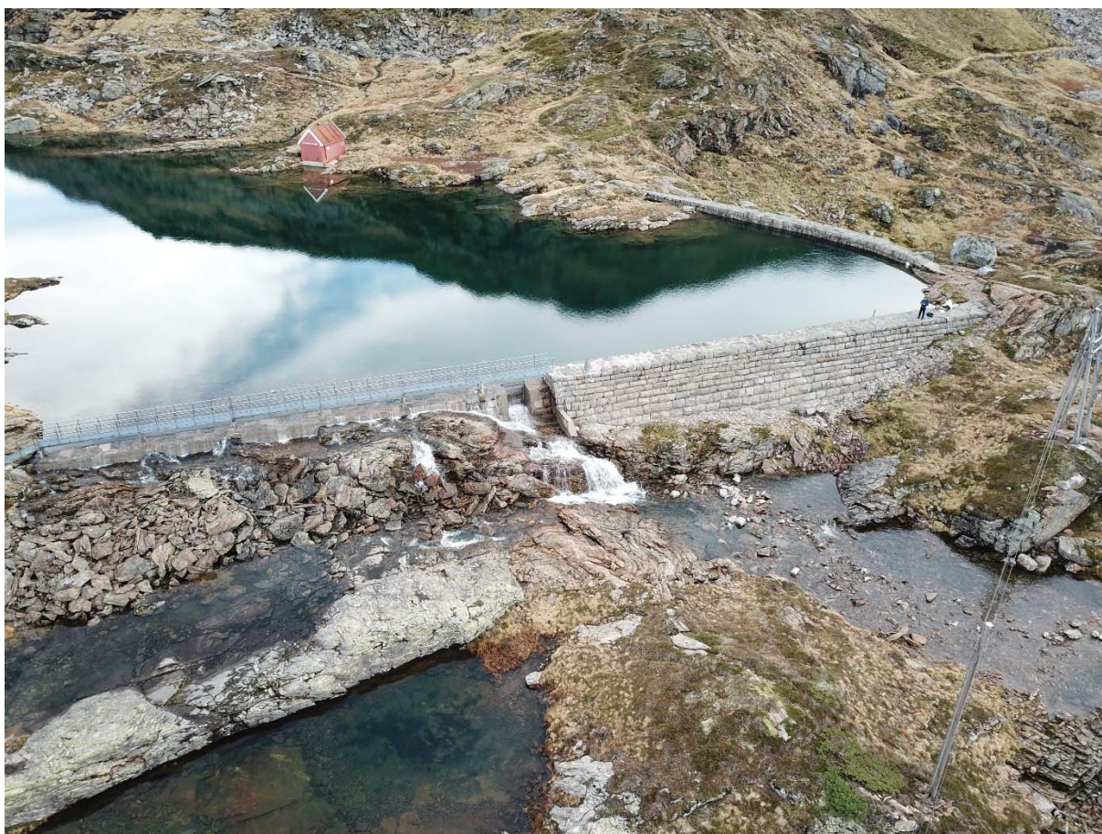
Figur 18: Overløpsdam, Dam 2 og Dam 3
