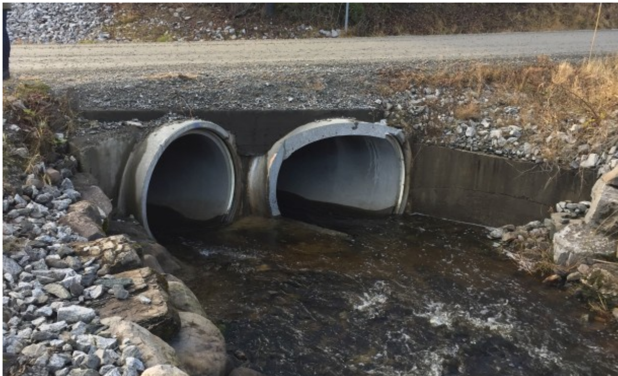
Figur 11. Kulvertkryssing ved modellprofil 894. Bilde fra oppstrøms side mot vest. Diameter 2 x 1400 mm. Foto: Asplan Viak 09.11.2017
