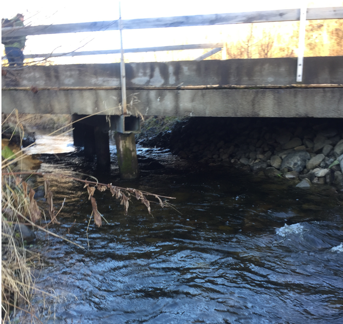
Figur 8. Bru for turvei ved modellprofil 1274. Liten avstand ned til vannspeil. Bilde fra nedstrøms side mot nordøst (oppstrøms). Foto: Asplan Viak, 09.11.2017
