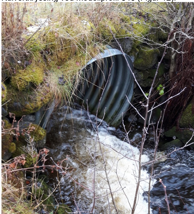
Figur 12. Kulvertkryssing ved modellprofil 846. Diameter 1600 mm. Foto: Hamar kommune, 25.10.2017
