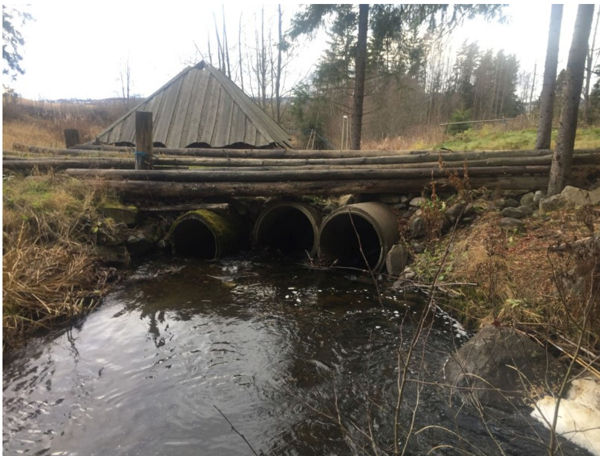
Figur 13. Bru/kulvertkryssing for turvei ved modellprofil 610. Bilde mot vest. Diameter 800, 900 og 1000 mm. Foto: Asplan Viak, 09.11.2017
