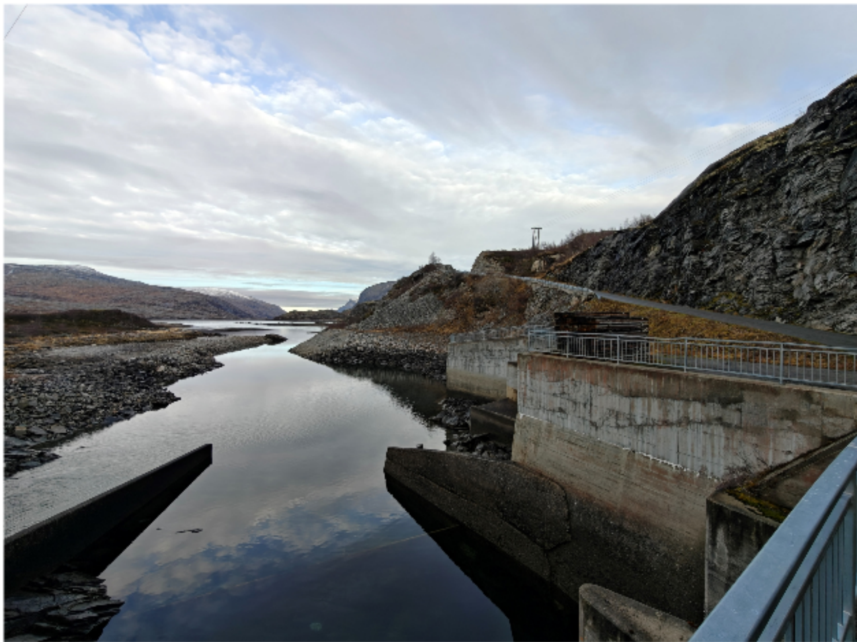
Utløpskanal Osbu kraftverk
