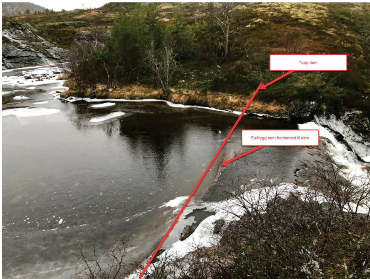
Bilde 3 Fjellrygg og damplassering
