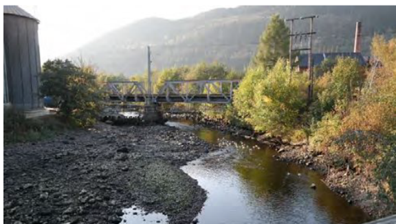
Bro ved mølle, 27.9.17, Sokna ikke i drift, 0,1m 3 /s
