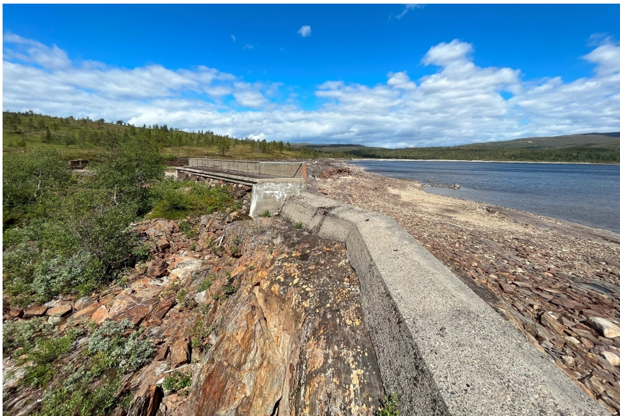
Figur 9: Demningen ved magasinet Samsjøen mot elva Sama (Foto: NVE).
