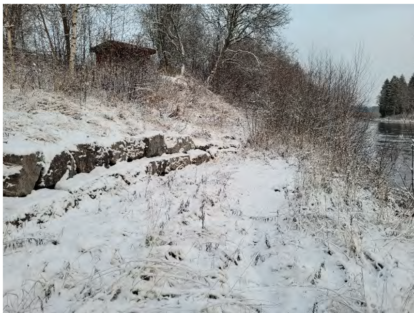
Figur 5: Bilde av eksisterende erosjonssikring innenfor tiltaksområdet (Foto Jon Birger Johnsen, 26.11.2021).
